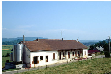
Façade antérieure de la fromagerie. Phot. Laurent Poupard IVR43_19923901197ZA
