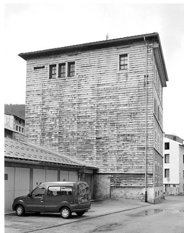
Elévation postérieure, de trois quarts droite. Phot. Yves Sancey IVR43_20033900453X
