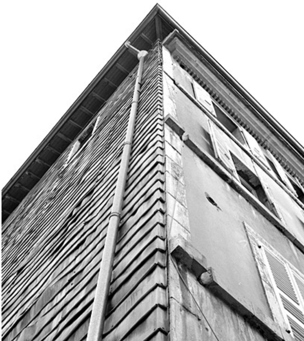
Angle des murs sud et est.
