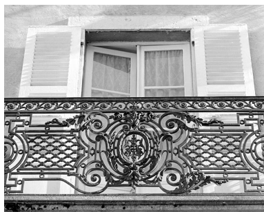
Balcon du premier étage : détail du garde-corps. Phot. Yves Sancey IVR43_20033900459X
