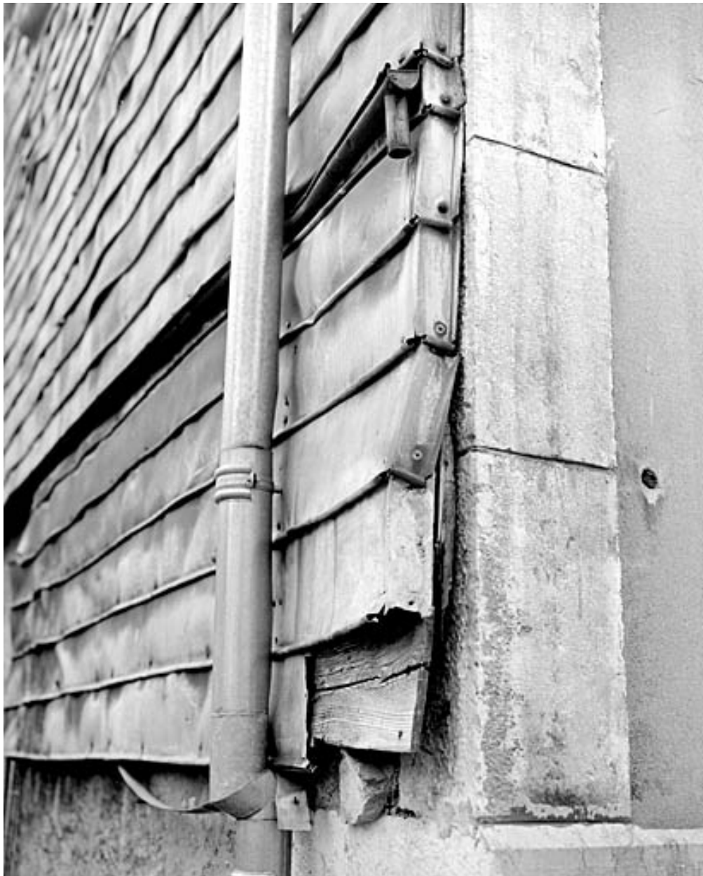
Essentage de tôle sur le mur sud.
