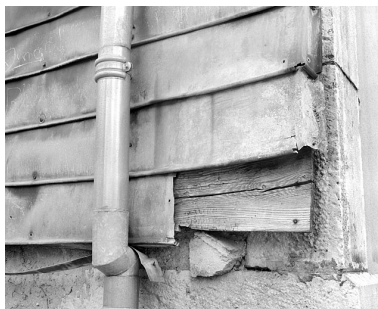
Essentage de tôle sur le mur sud : détail. Phot. Yves Sancey IVR43_20033900456X
