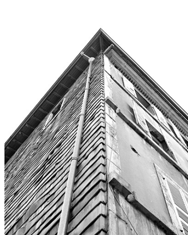
Angle des murs sud et est.
