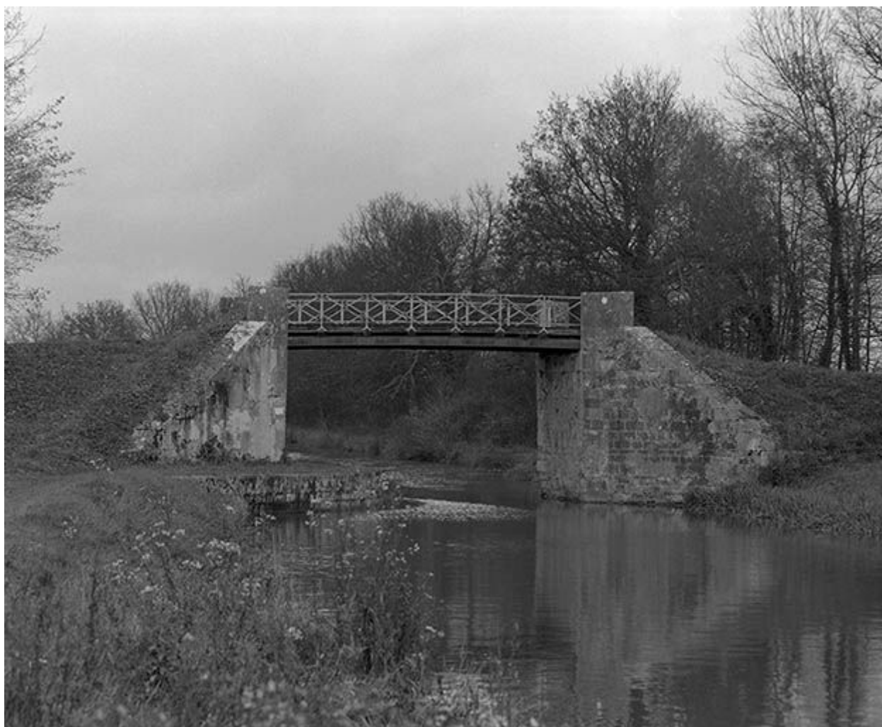
Vue d'ensemble prise de l'amont.
