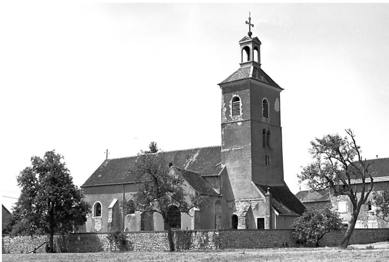
Façade latérale sud.
