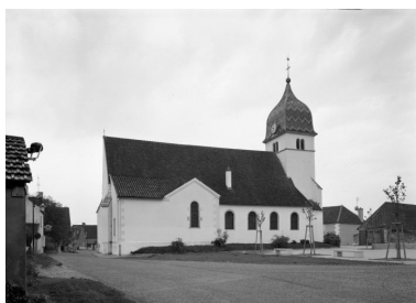
Elévation gauche. Phot. Michel Rosso IVR26_20017101213V
