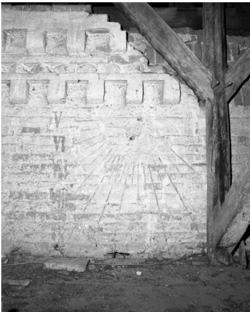
Comble de la chapelle droite : cadran solaire.
