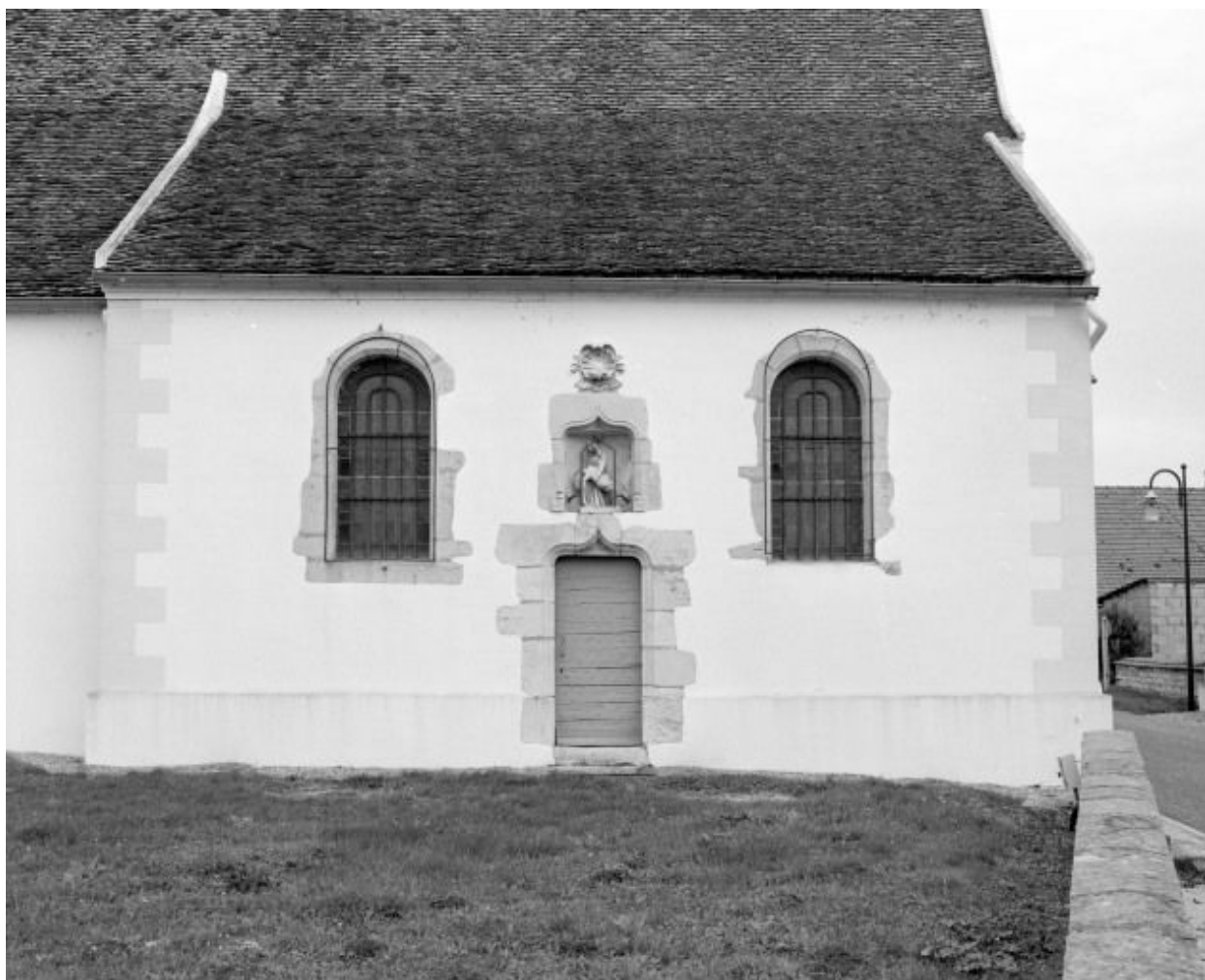
Elévation latérale de la chapelle gauche.
