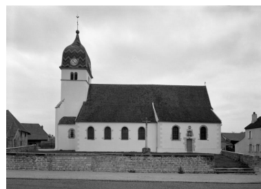
Elévation gauche. Phot. Michel Rosso IVR26_20017101215V
