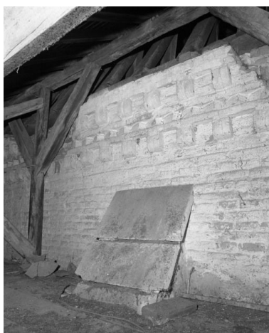
Comble de la chapelle droite : chaperon d'un contrefort. Phot. Michel Rosso IVR26_20017101211X
