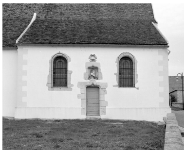
Elévation latérale de la chapelle gauche. Phot. Michel Rosso IVR26_20017101216X
