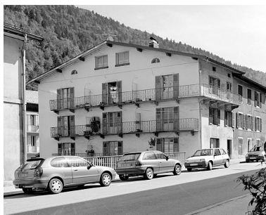
Vue d'ensemble, depuis le nord- ouest (rue de la République). Phot. Yves Sancey IVR43_20033900352X
