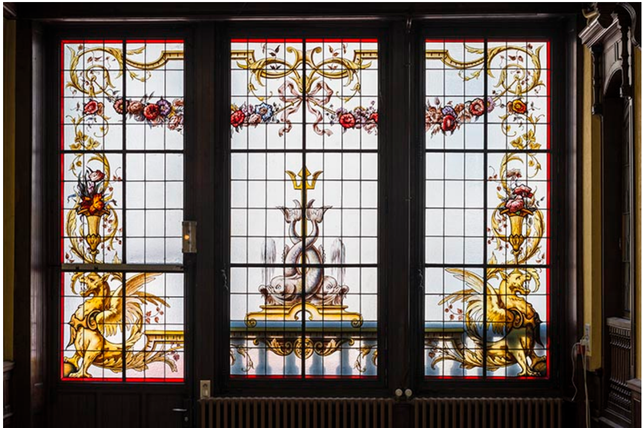
Vue générale de la verrière, côté rue.
