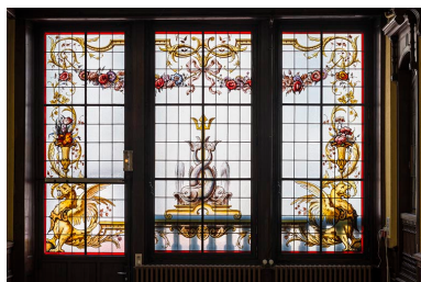
Vue générale de la verrière, côté rue. Phot. Jérôme Mongreville IVR43_20177000850NUC4A
