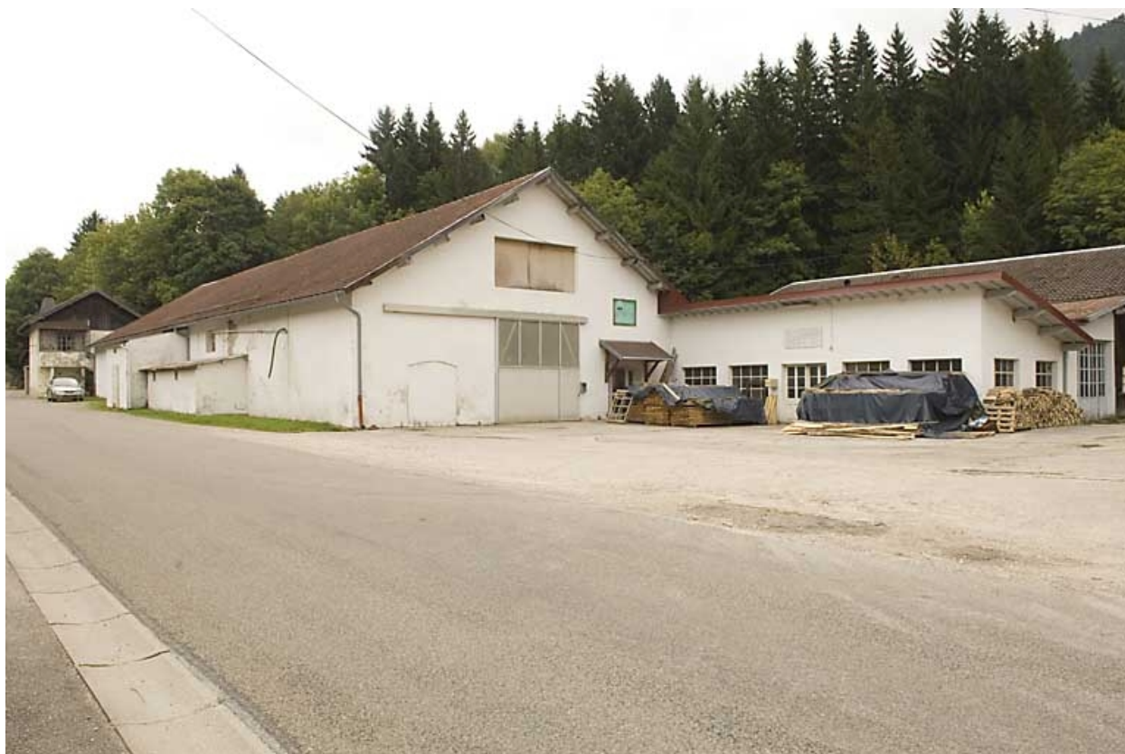
Partie nord du site : vue générale.
