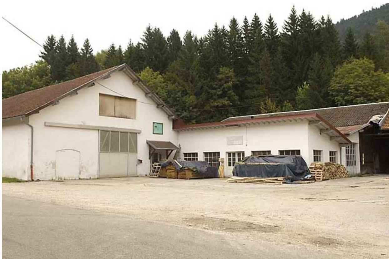
Partie nord : vue rapprochée.
