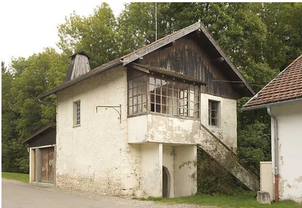
Partie nord : maison.
