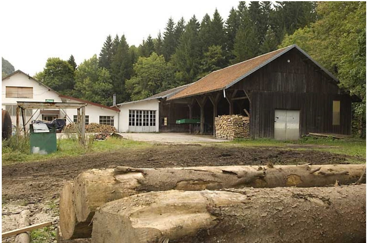
Partie nord : hangar.
