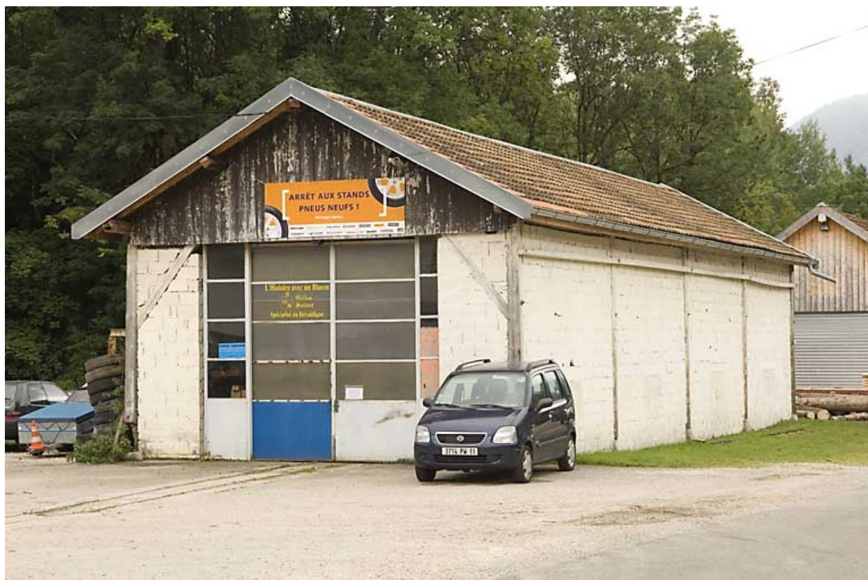
Partie sud : 1er bâtiment.
