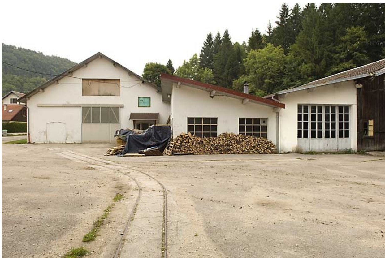
Partie nord : bâtiments vus de face.
