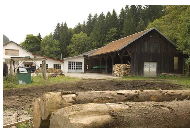
Partie nord : hangar. Phot. Jérôme Mongreville IVR43_20082501071NUC2A
