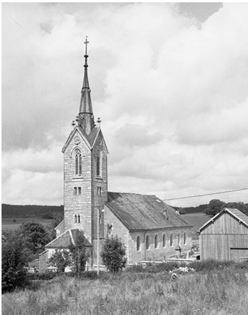
Extérieur : faces antérieure et latérale droite.
