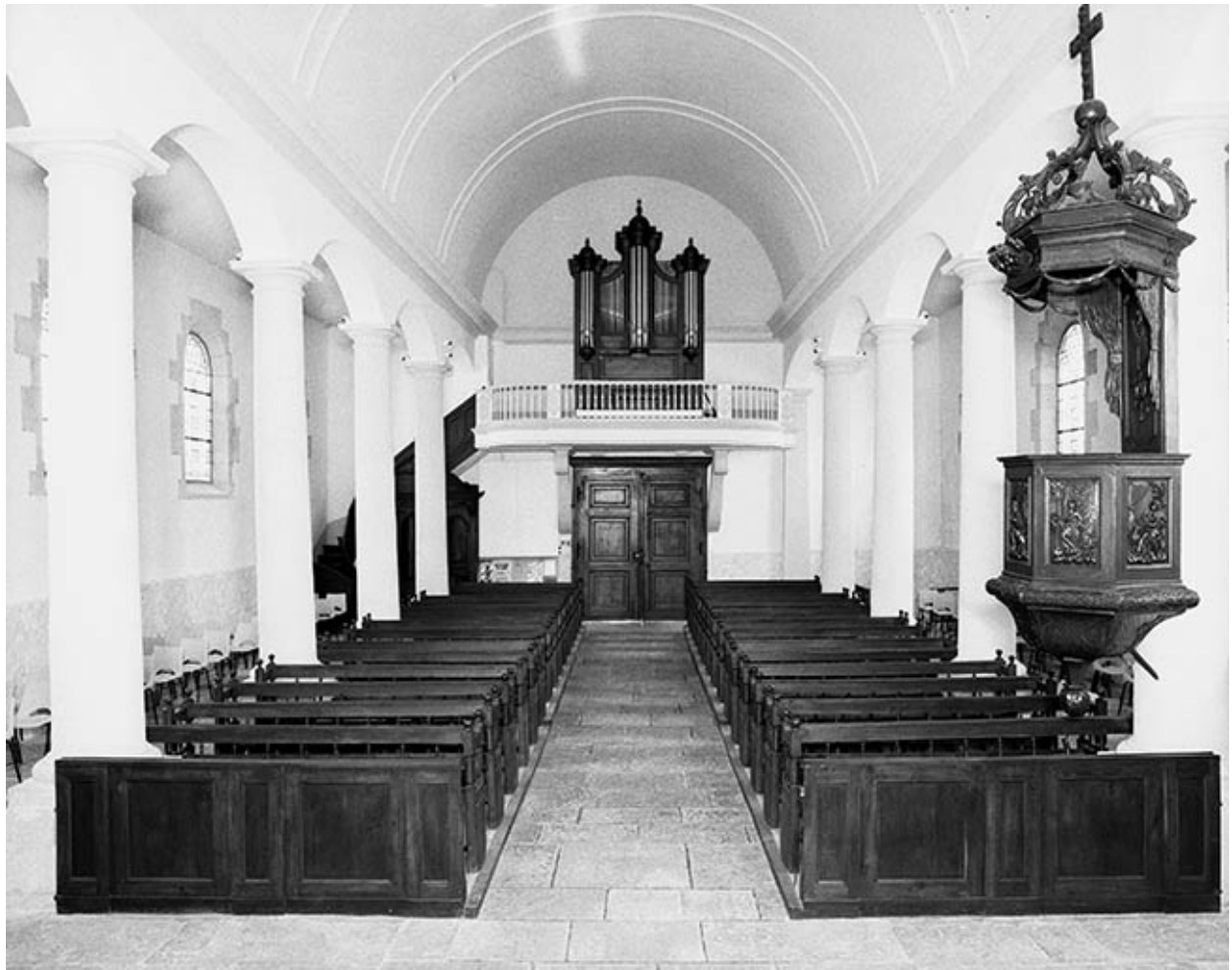
Intérieur : nef depuis le chœur.
