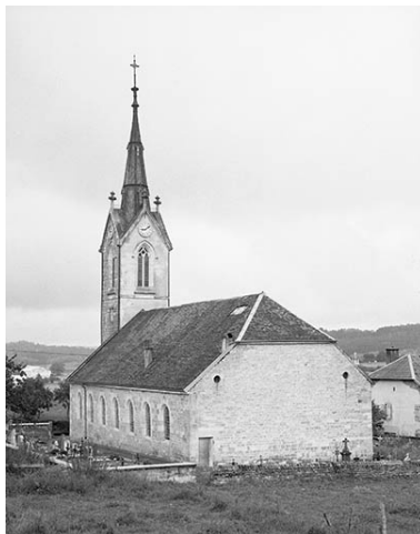
Extérieur : chevet et face latérale droite. Phot. Yves Sancey IVR43_19752500464X
