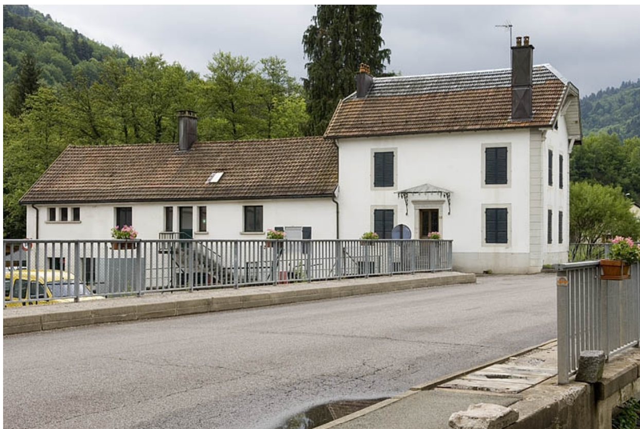
Le bâtiment de l'ancien moulin.
