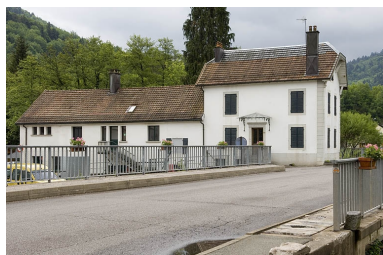
Le bâtiment de l'ancien moulin. Phot. Jérôme Mongreville IVR43_20067000415NUCA
