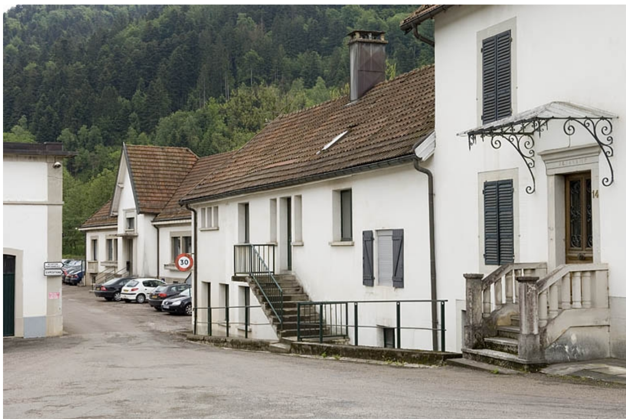
Les bureaux vus depuis l'entrée.
