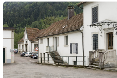
Les bureaux vus depuis l'entrée. Phot. Jérôme Mongreville IVR43_20067000416NUCA
