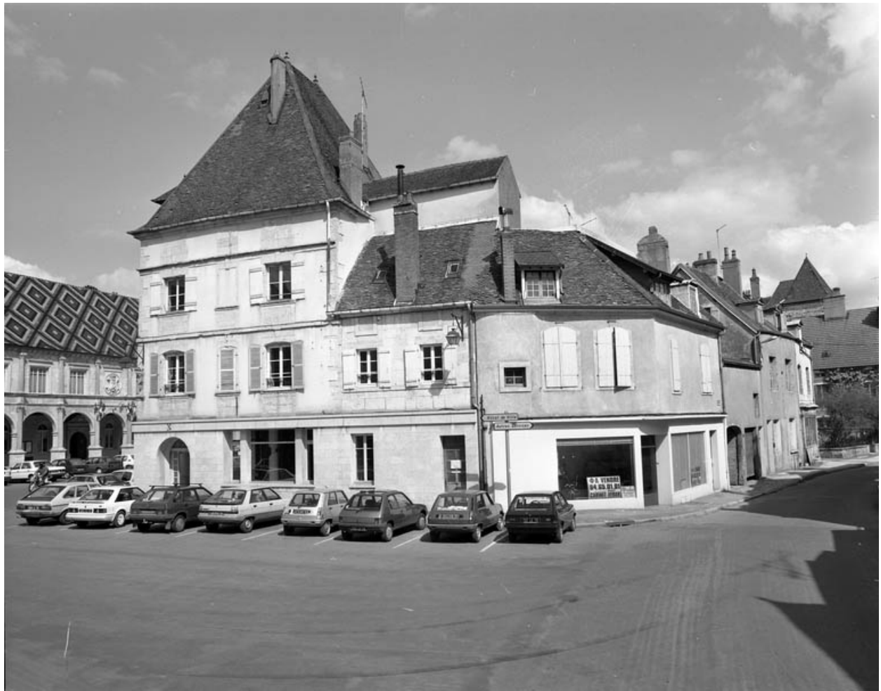
Façade latérale droite.
