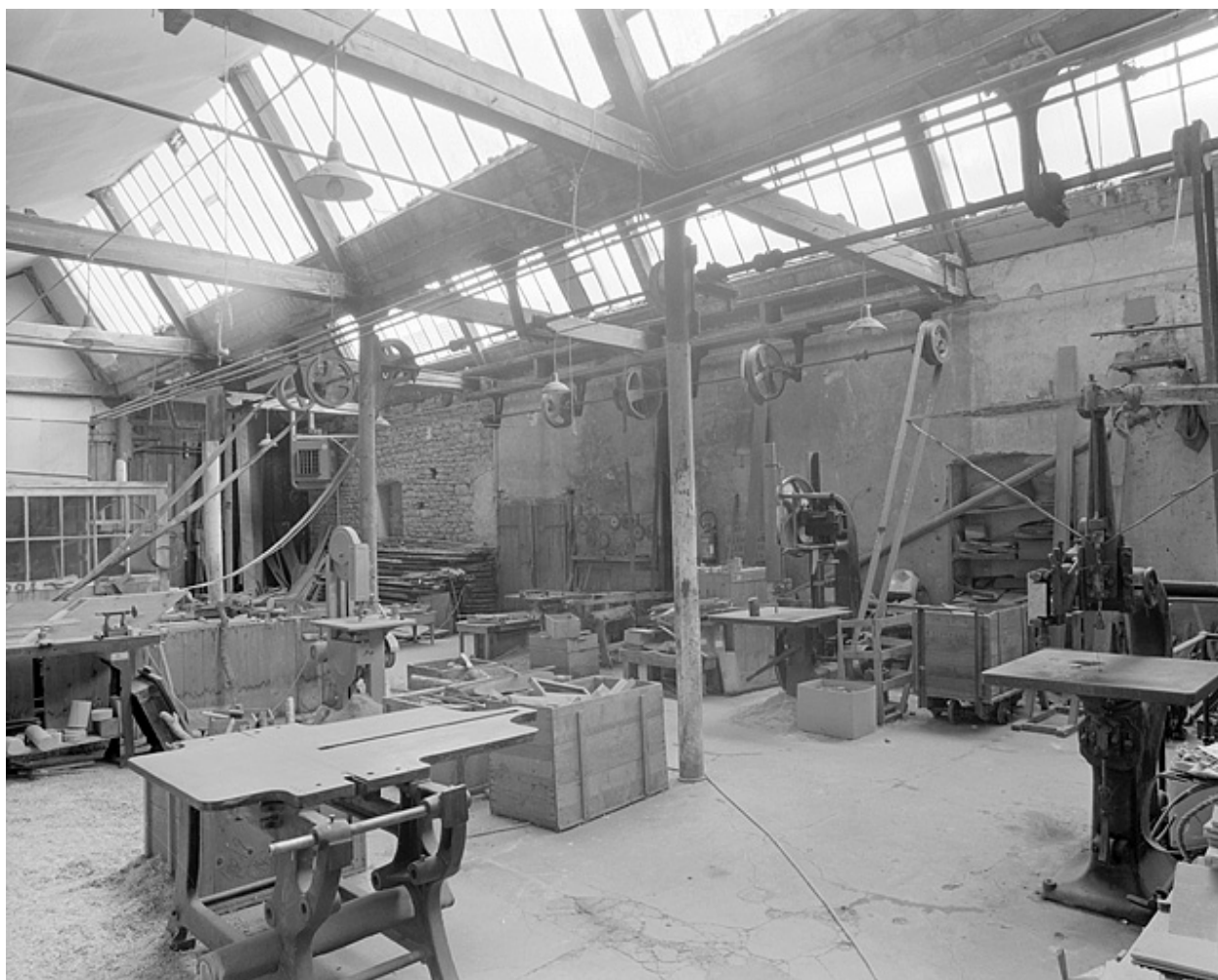
Vue d'ensemble de l'atelier depuis le sud-est.
