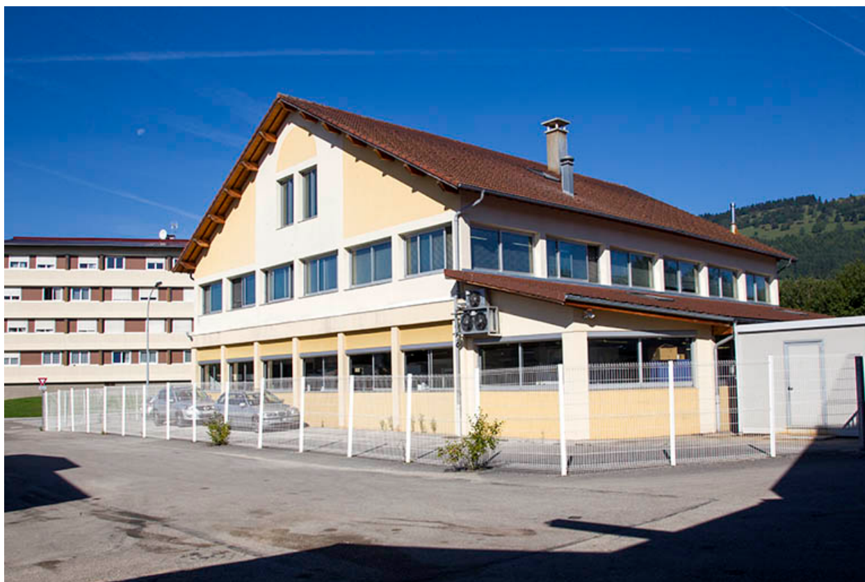
Façades postérieure et latérale droite.
