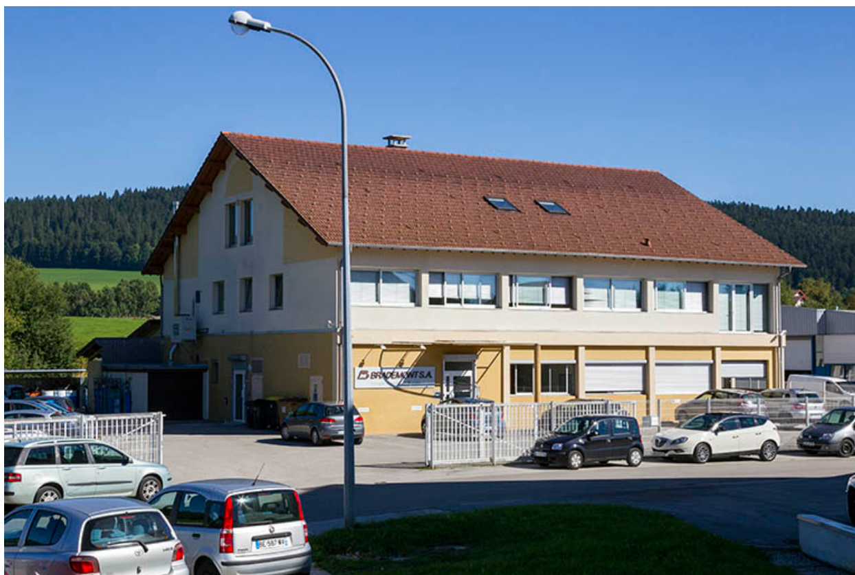
Façades antérieure et latérale gauche.
