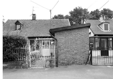
Maison individuelle n ° 9 rue du Temple. Phot. Yves Sancey IVR43_20029000335X
