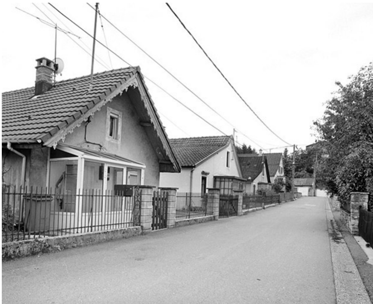
Alignement de maisons rue du Temple.
