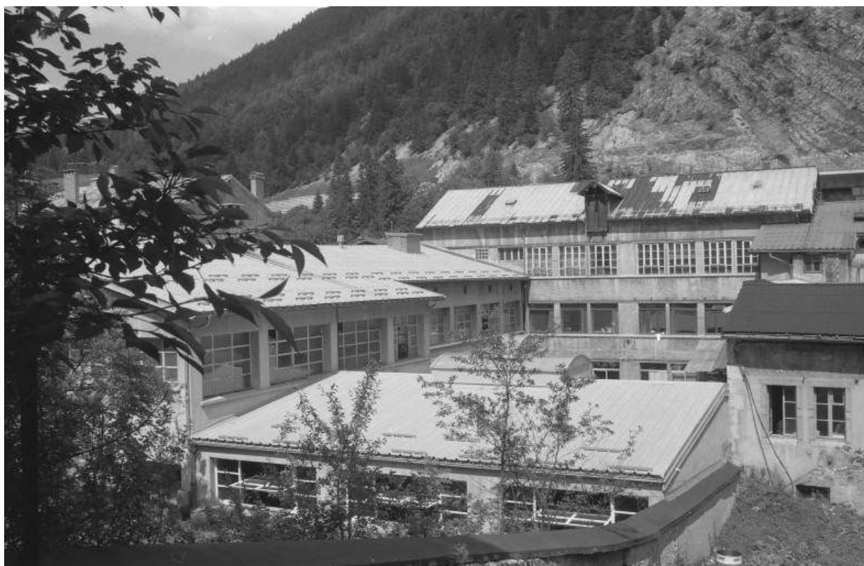
Façade postérieure des ateliers au n° 194.
