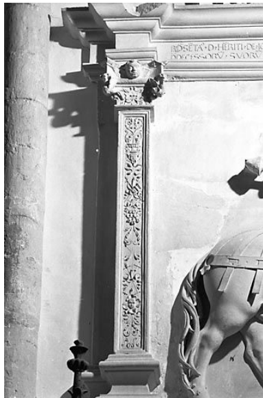
Détail : pilastre gauche. Phot. Yves Sancey IVR43_19782500824Z
