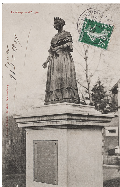
La Marquise d'Aligre (Laurent Taillandier, lib.-édit., Bourbon-Lancy). (carte postale ancienne, Collection particulière) Repro. Pierre-Marie Barbe-Richaud, Autr. auteur inconnu IVR26_20107100741NUC2A
