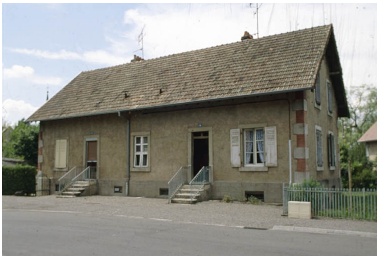
Maison à deux logements rue Kléber.
