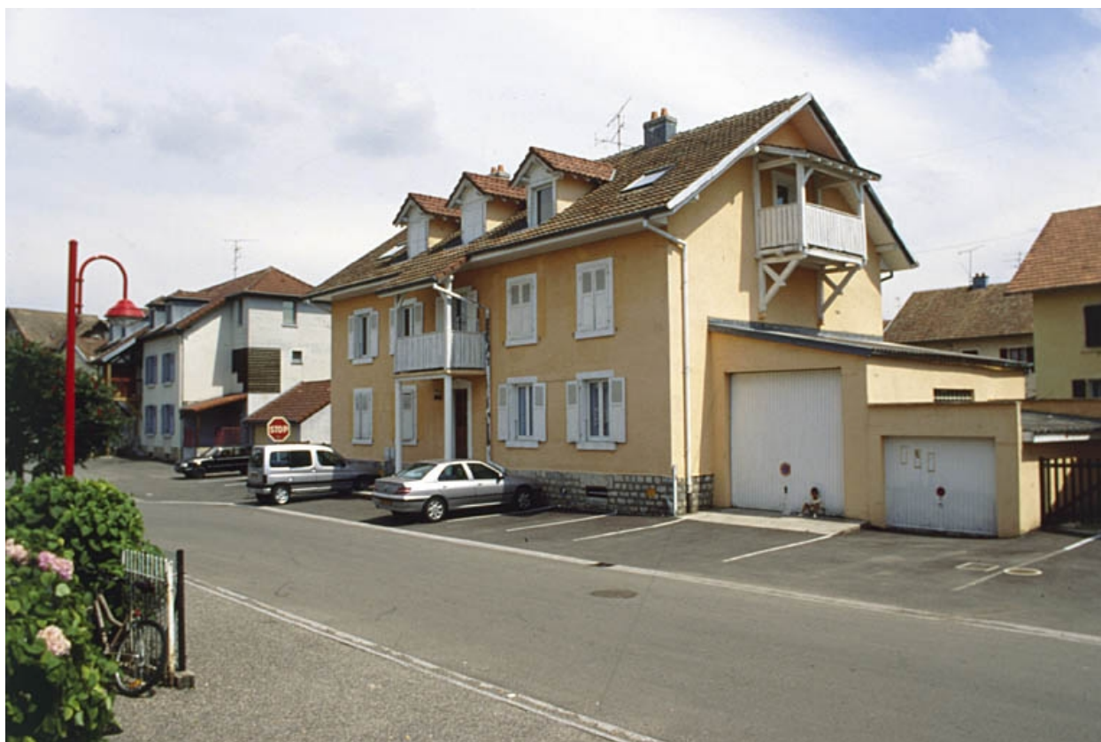
Logements collectifs rue Kléber.
