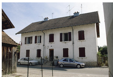
Une maison à quatre logements. Phot. Yves Sancey IVR43_20019000333ZA
