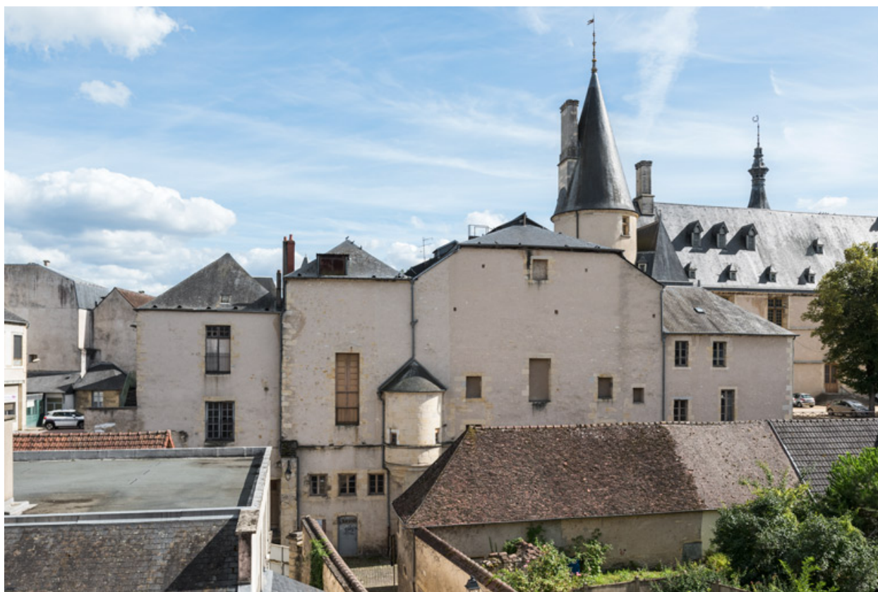
Vue d'ensemble, depuis le nord (façade postérieure).
