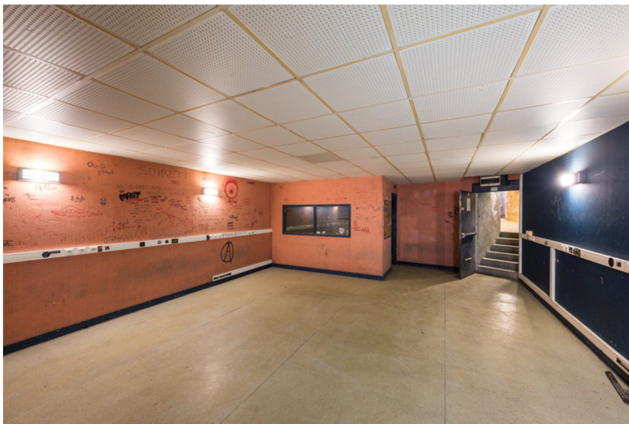
Etage de soubassement, partie gauche : salle d'enregistrement.
