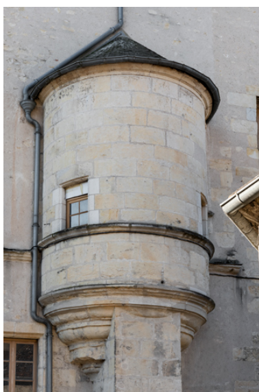
Façade postérieure : échauguette. Phot. Pierre-Marie Barbe-Richaud IVR26_20235800218NUC4A
