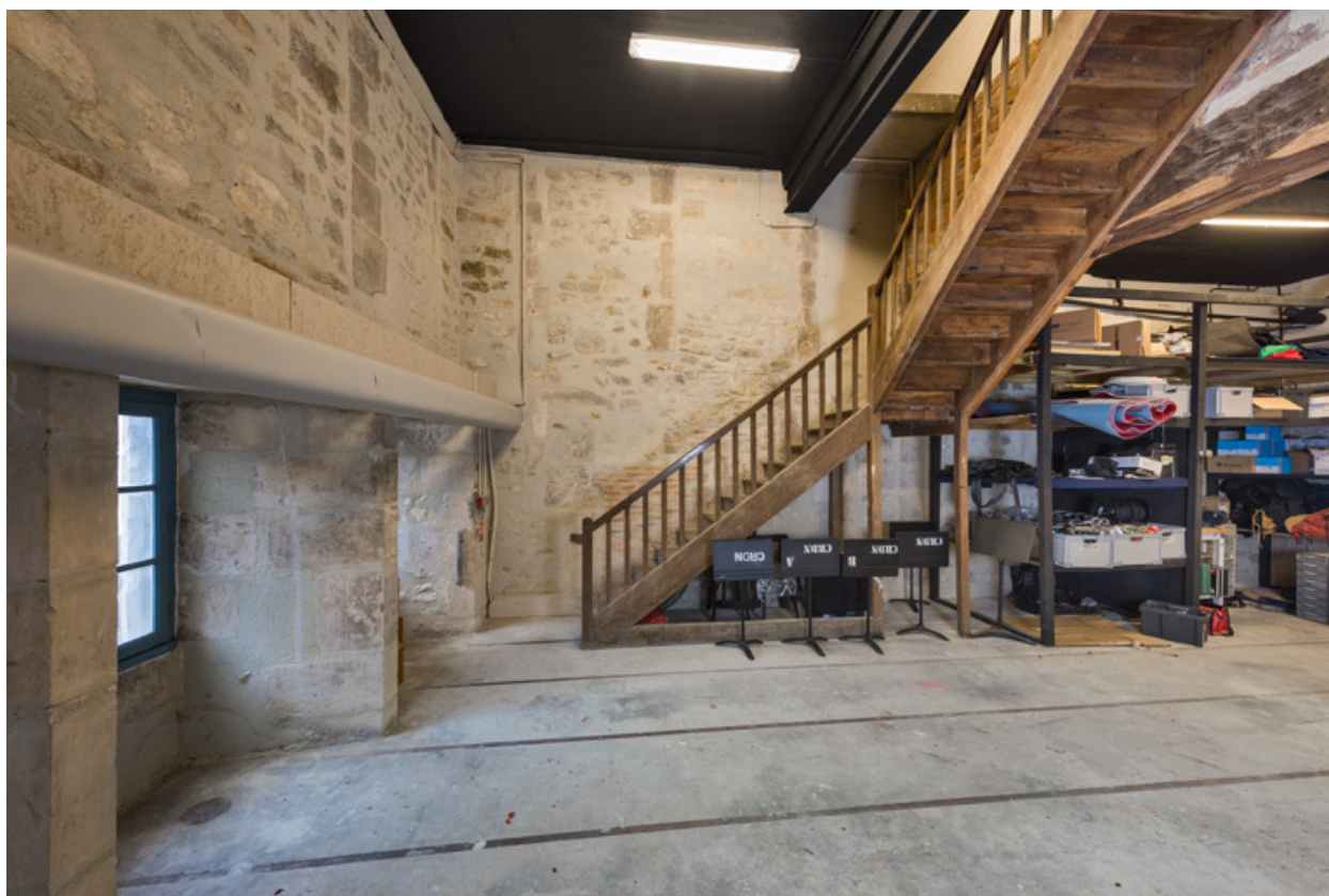
Aile orientale : magasin à l'étage de soubassement.
