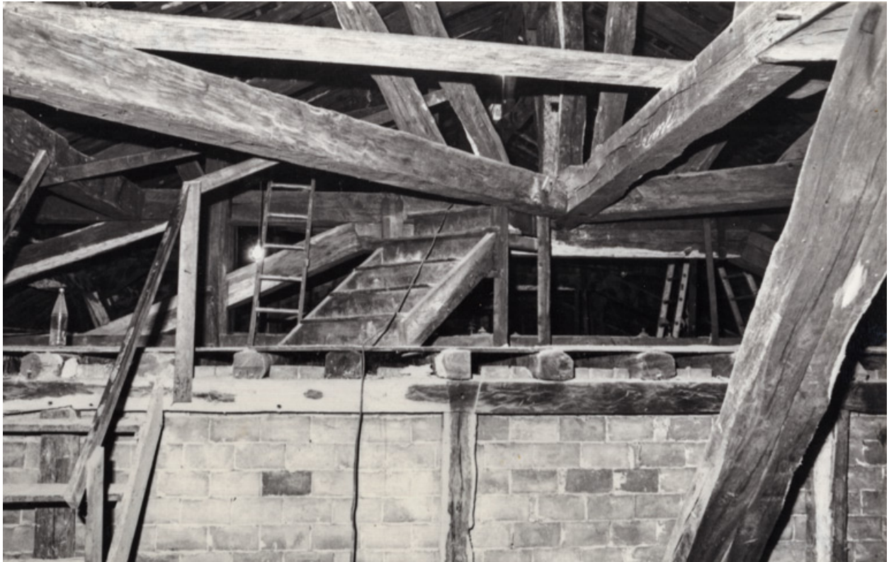
Théâtre, comble, machinerie [comble et charpente]. 2 février 1977. (Archives municipales, Nevers : 6 Fi 3345).
