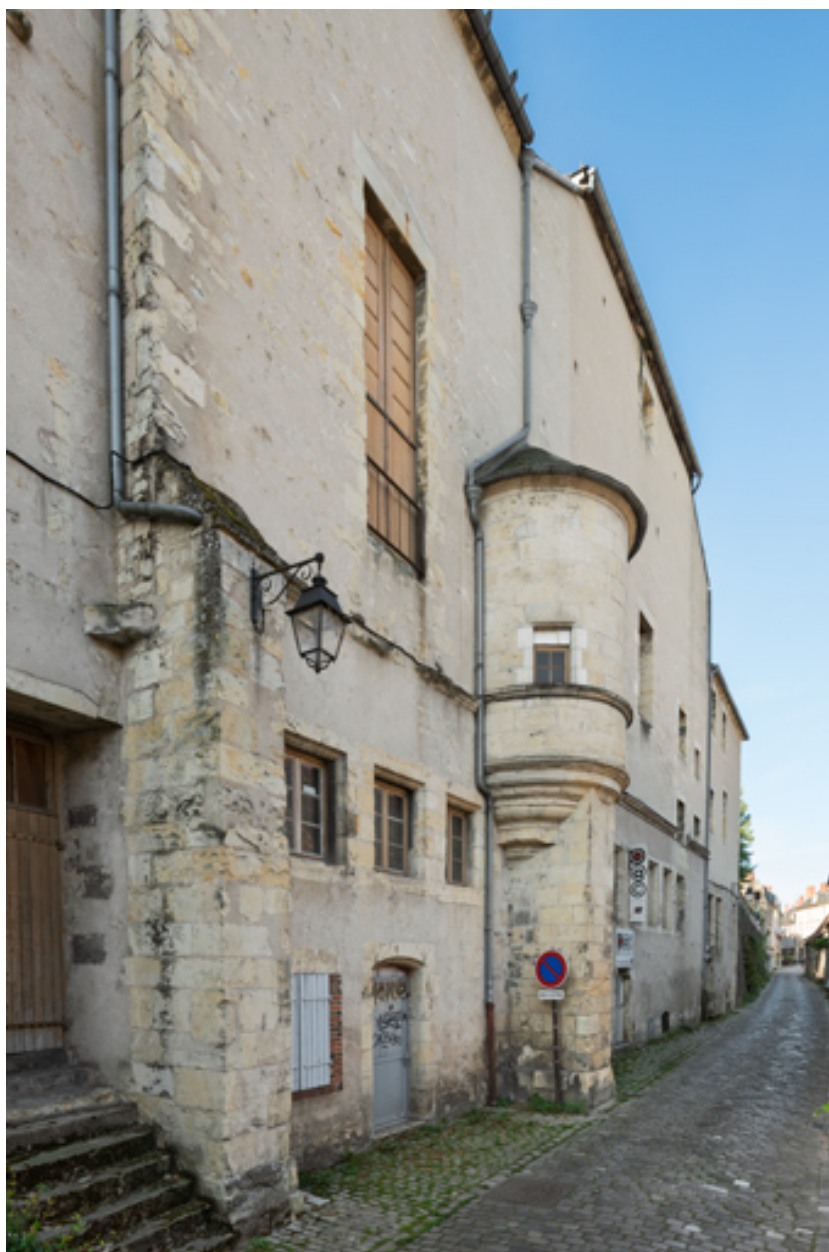
Façade postérieure, vue en enfilade.
