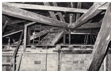
Théâtre, comble, machinerie [comble et charpente]. 2
