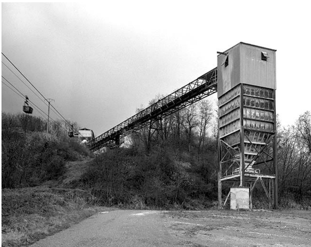
L'entrée de la carrière. Au premier plan : silo à gypse, relié par convoyeur à l'atelier de concassage.
