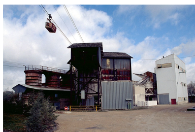
Poste de chargement : réception des bennes de gypse du transporteur par câbles. Phot. Yves Sancey IVR43_19973900387ZA
