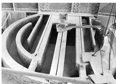
[Four à gypse dit plateau 5]. Phot. Yves Sancey IVR43_19963901193X
