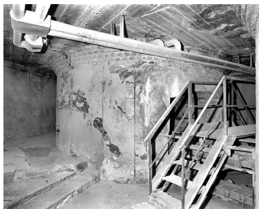
Soubassement d'un four à surcuit. Phot. Yves Sancey IVR43_19973900382X
