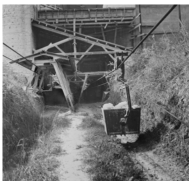
[Départ du transporteur automatique par câbles et télébennes]. Phot. Yves Sancey IVR43_19963901203X
