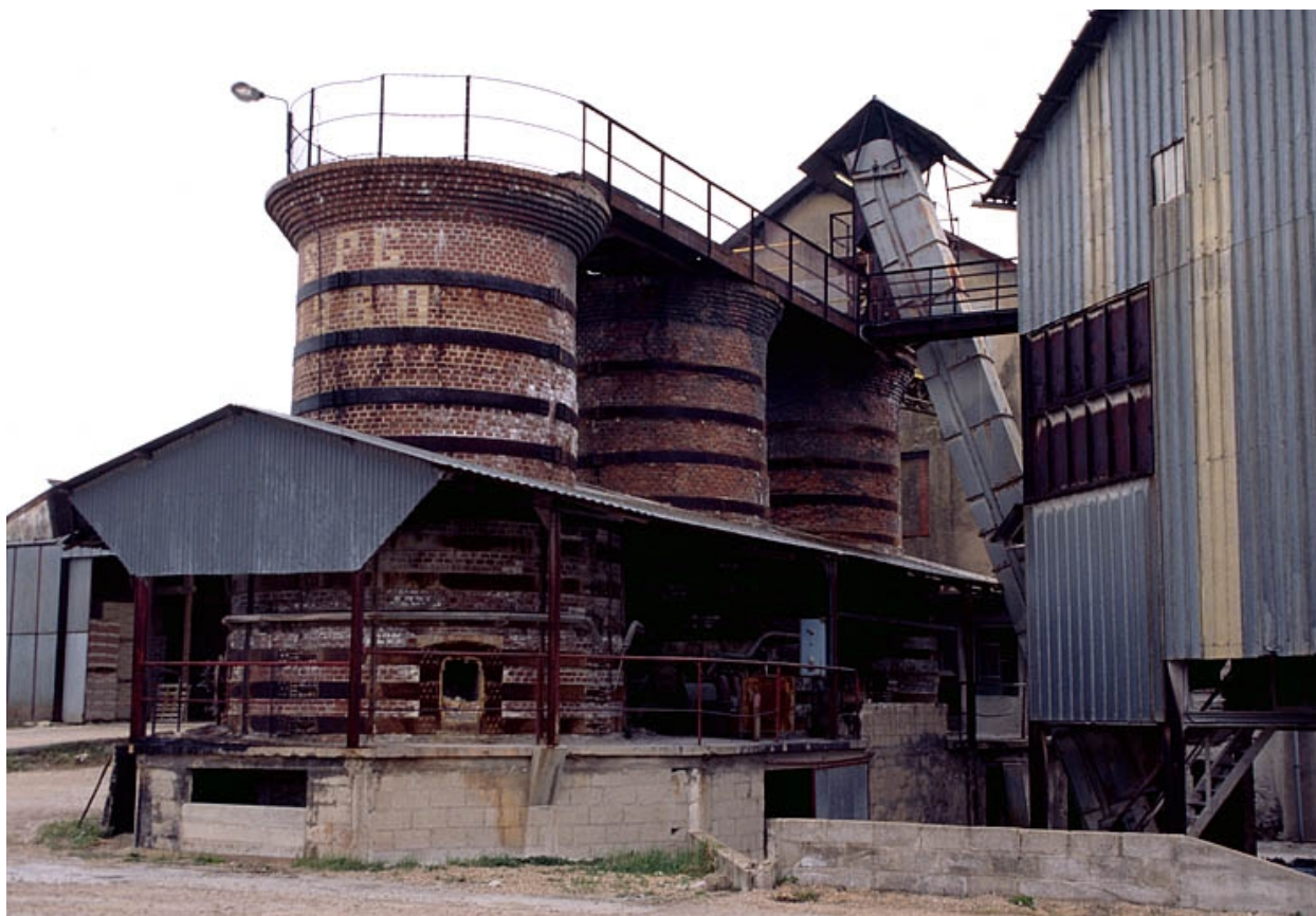
Les fours à surcuit depuis le sud.
