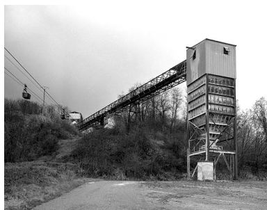
L'entrée de la carrière. Au premier plan : silo à gypse, relié par convoyeur à l'atelier de concassage. Phot. Yves Sancey IVR43_19973900408X
