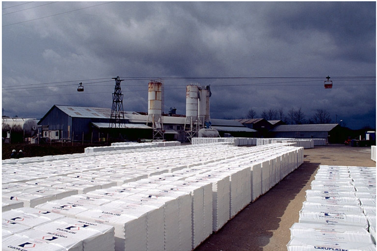
Vue d'ensemble depuis l'est (partie sud).
