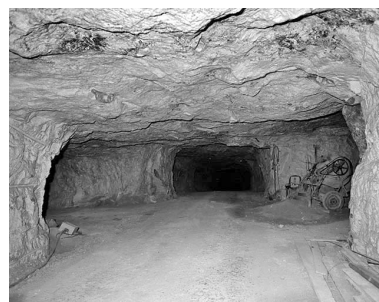
Galerie d'accès et vaisseaux transversaux. Phot. Yves Sancey IVR43_19973900411X
