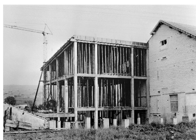
[Construction de l'atelier dit du plateau 5]. Phot. Yves Sancey IVR43_19963901195X
