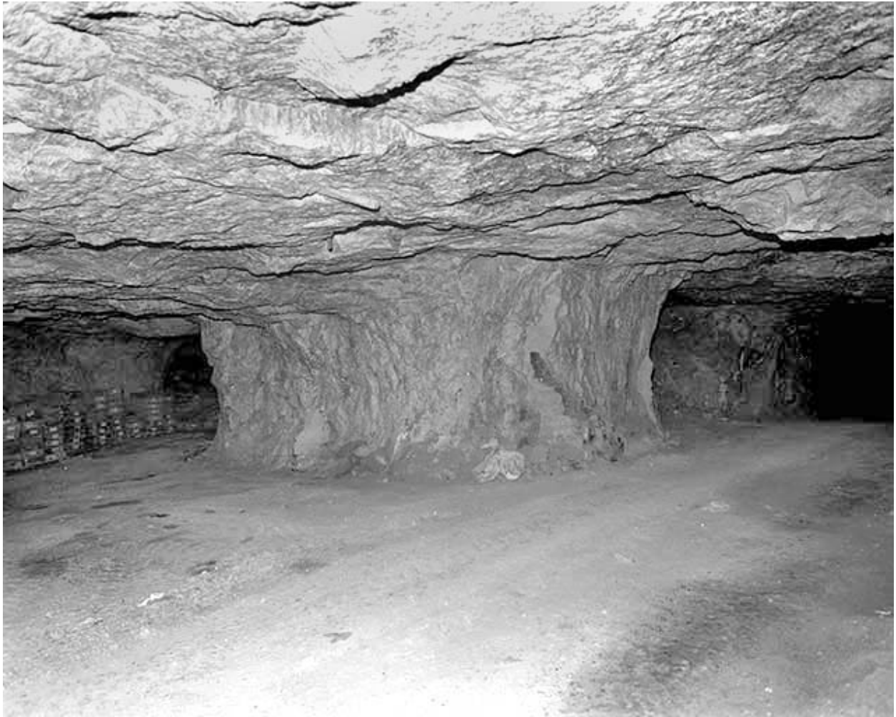
Pilier de soutènement d'une ancienne chambre d'exploitation.
