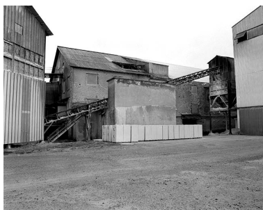
Bâtiment des fours. Au premier plan : convoyeur à gypse surcuit. Phot. Yves Sancey IVR43_19973900391X
