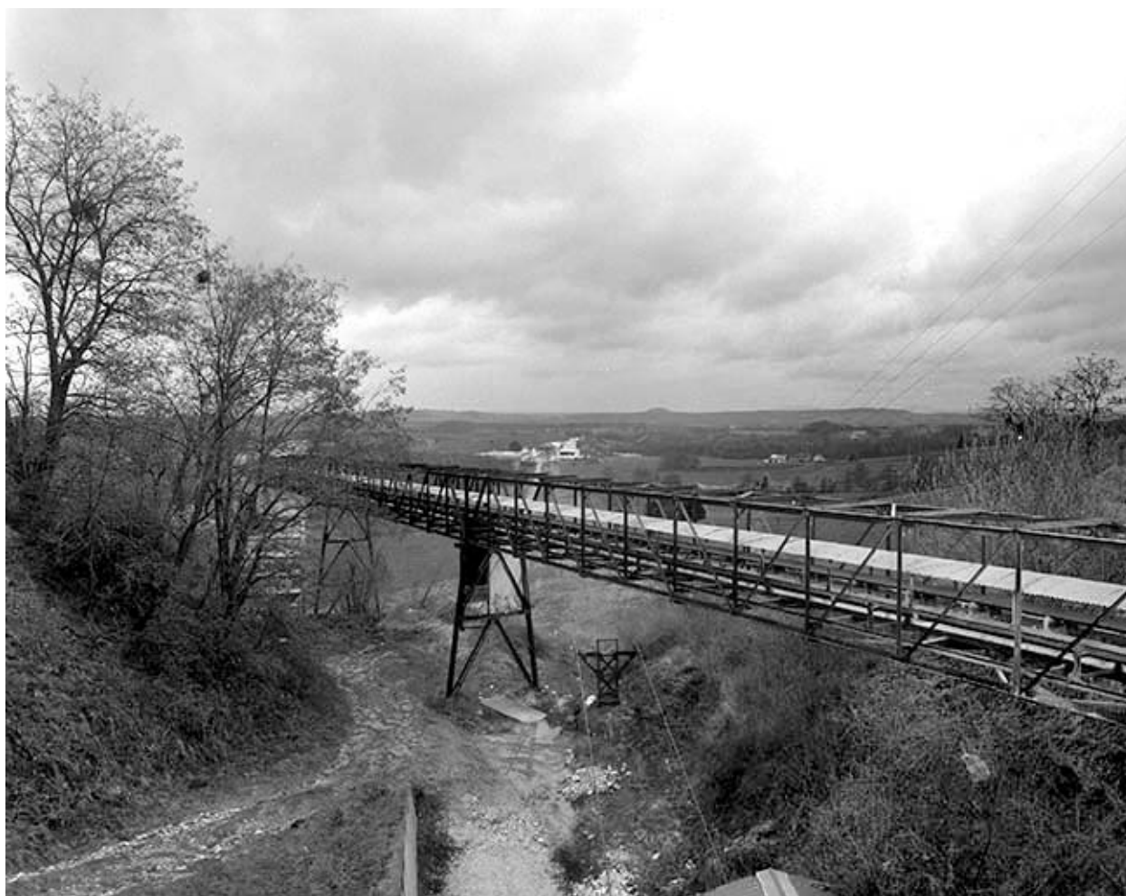
La plâtrière depuis l'atelier de distribution et de concassage de la carrière. Au premier plan : un convoyeur à bandes.
