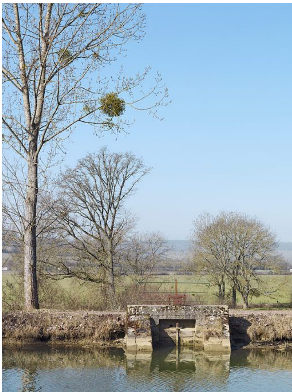
Le déversoir rive gauche de face.
