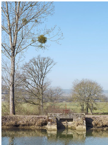
Le déversoir rive gauche de face.
