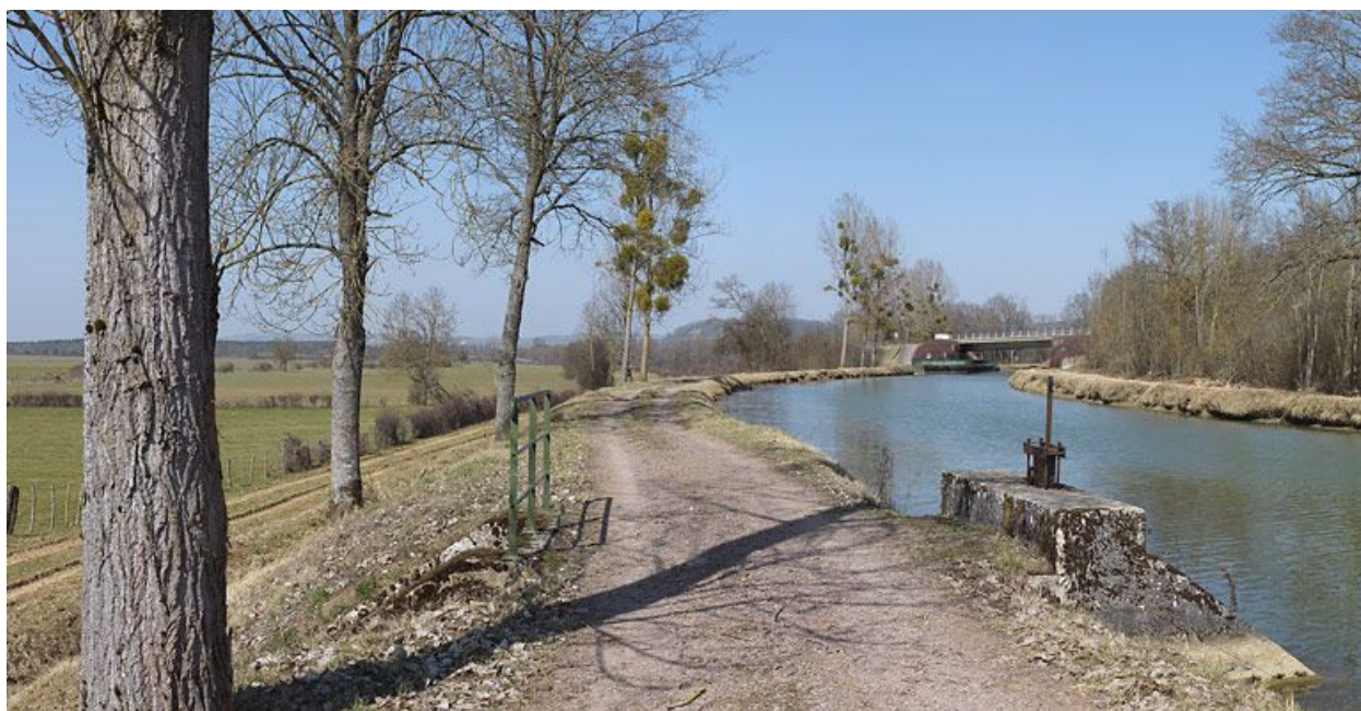
Le déversoir rive gauche dans son environnement.
