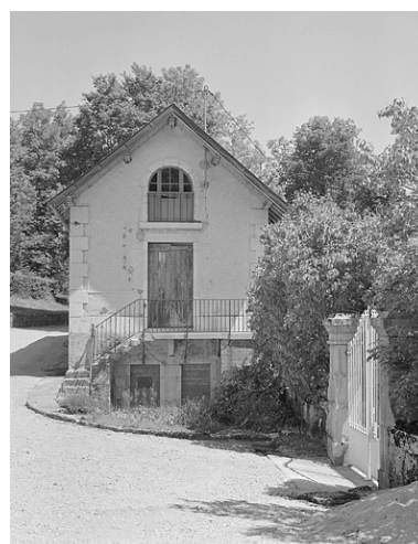
Façade antérieure du logement des jardiniers. Phot. Jérôme Mongreville IVR43_19973900797X
