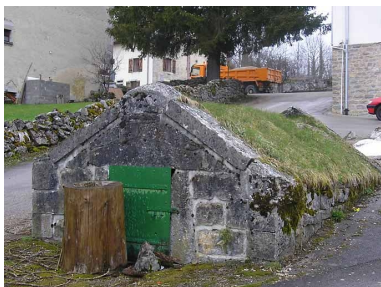
Vue de trois quarts sur ensemble hydraulique. Phot. Anne-Laure Madinier IVR43_20083900590NUC1A
