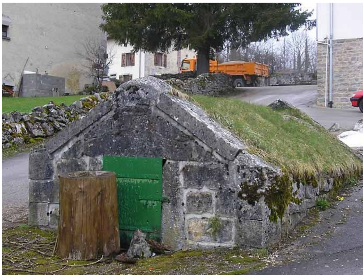
Vue de trois quarts sur ensemble hydraulique.
