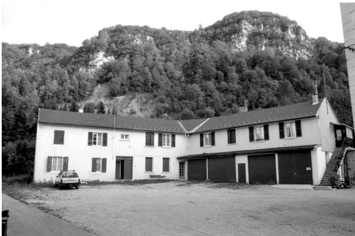
Anciens logements d'ouvriers.
