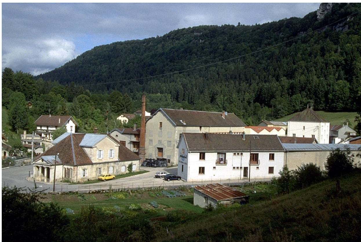
Entrée de l'usine.
