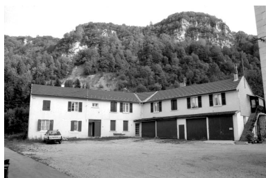
Anciens logements d'ouvriers.
