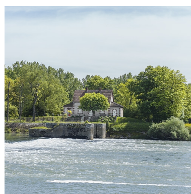
Maison du barragiste de l'ancien barrage du Châtelet (21). Phot. Thierry Kuntz IVR26_20172100537NUC2A
