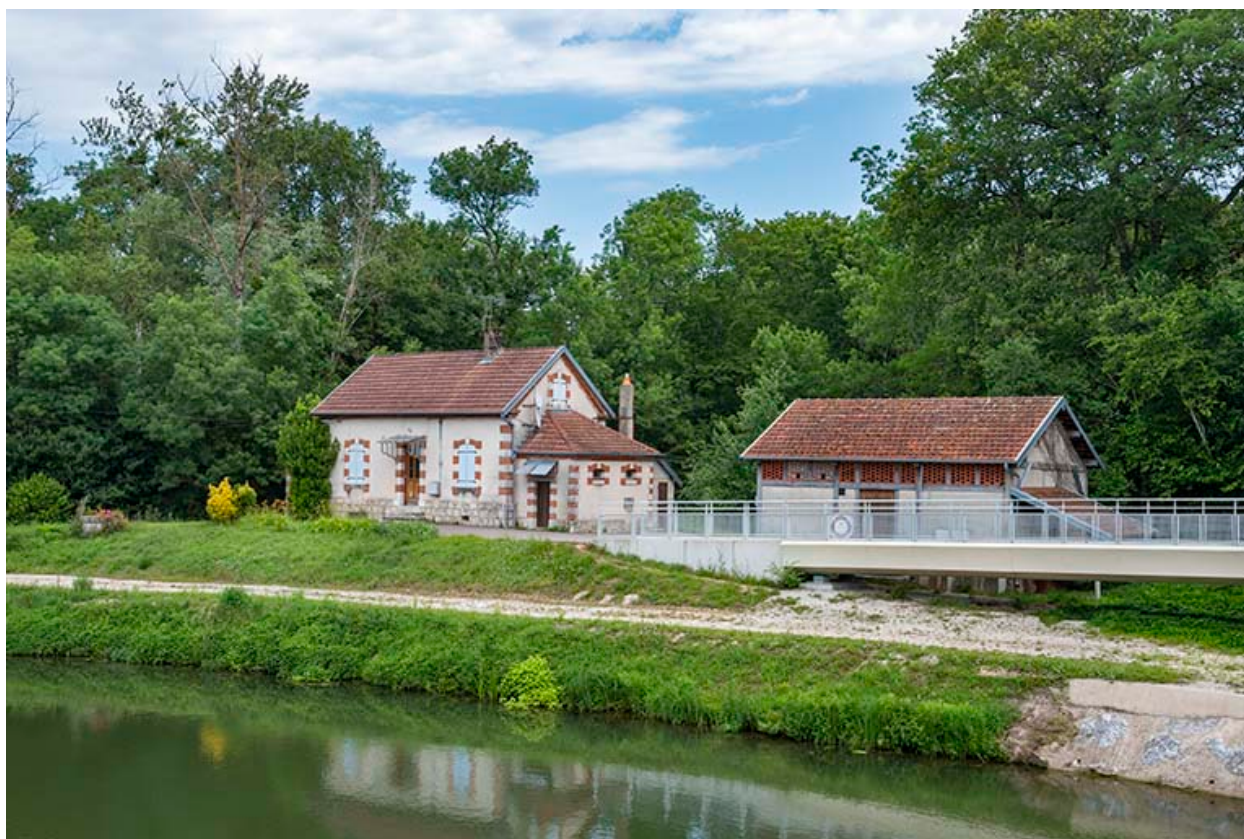
Maison du barragiste à Apremont (70).
