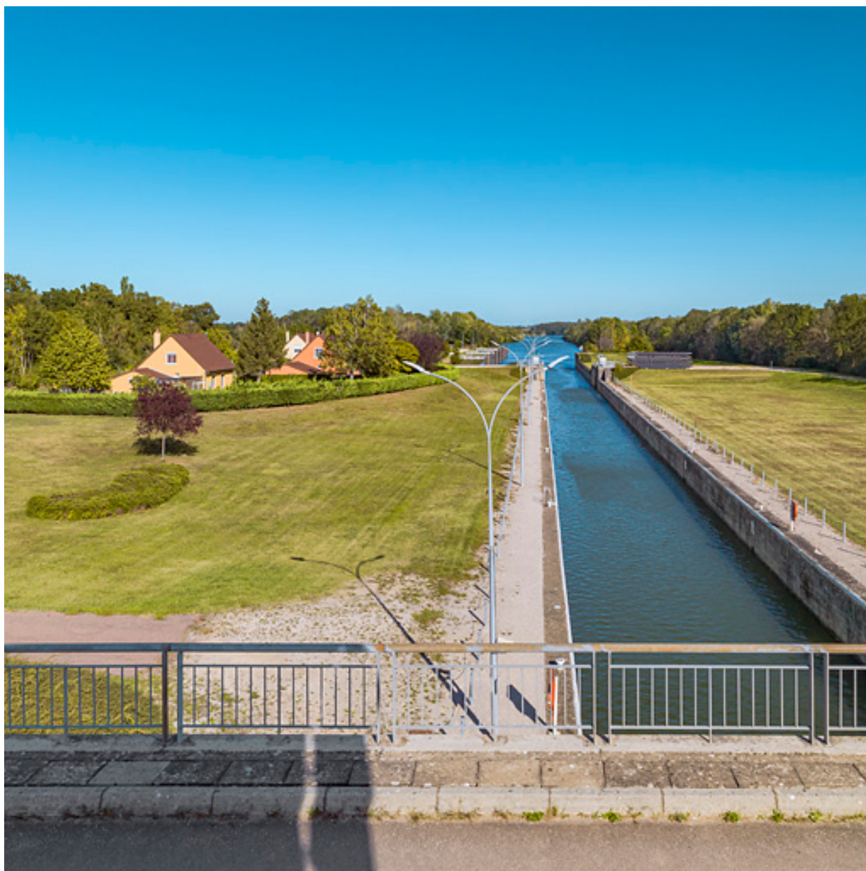
Le site d'écluse à grand gabarit d'Ecuelles (71).
