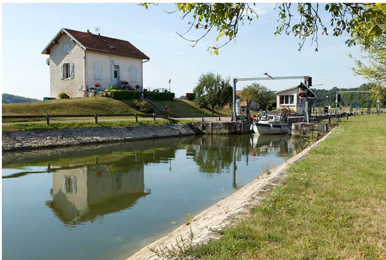
Site d'écluse de Sacey-sur-Saône (70).
