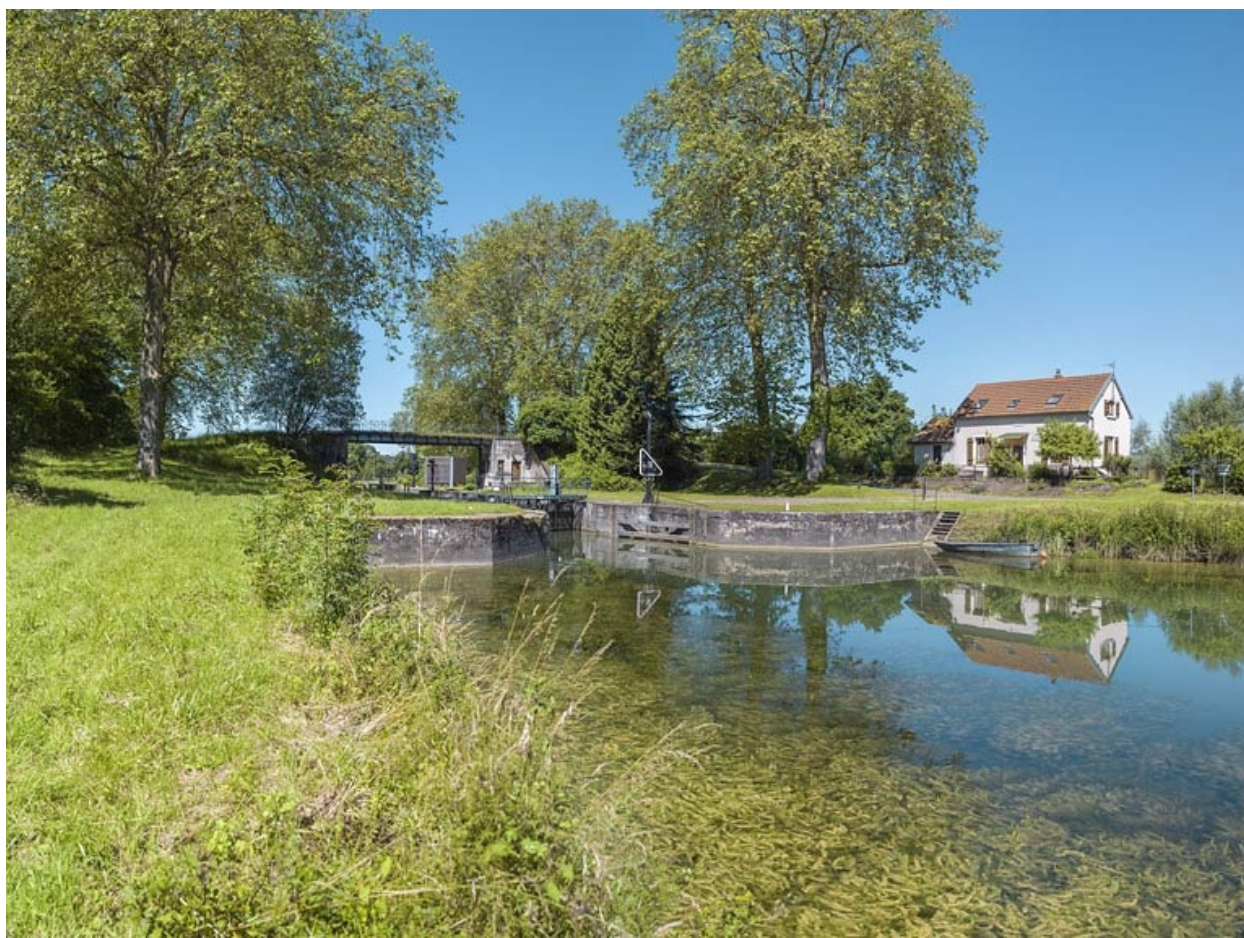
Maison éclusière et site de l'écluse 18 dite d'Heuilley (21).
