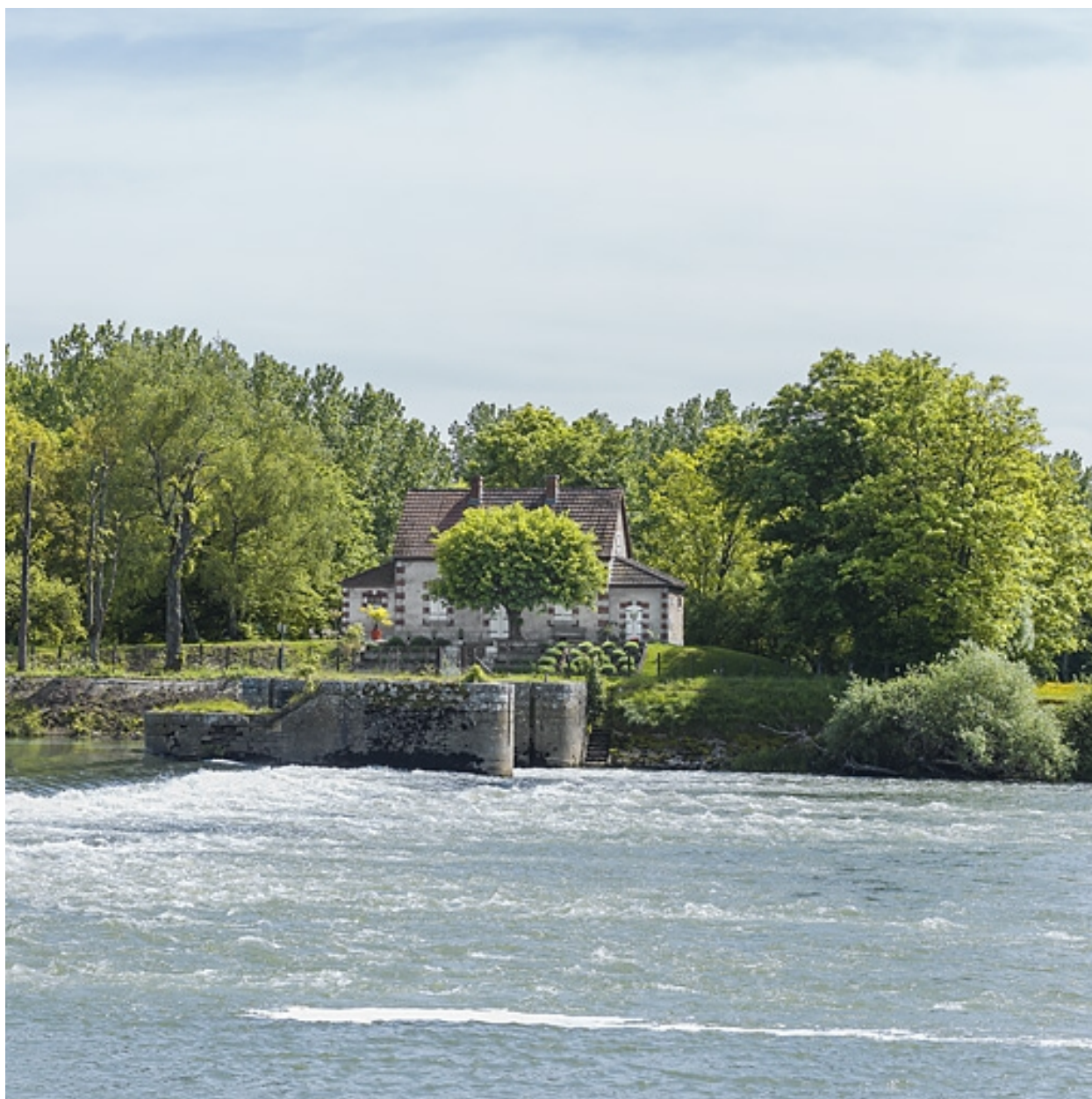
Maison du barragiste de l'ancien barrage du Châtelet (21).
