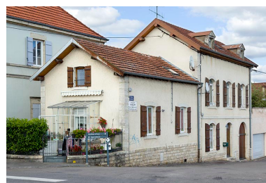
La maison du site d'écluse à Gray (70). Phot. Sonia Dourlot IVR43_20157000872NUC2A
