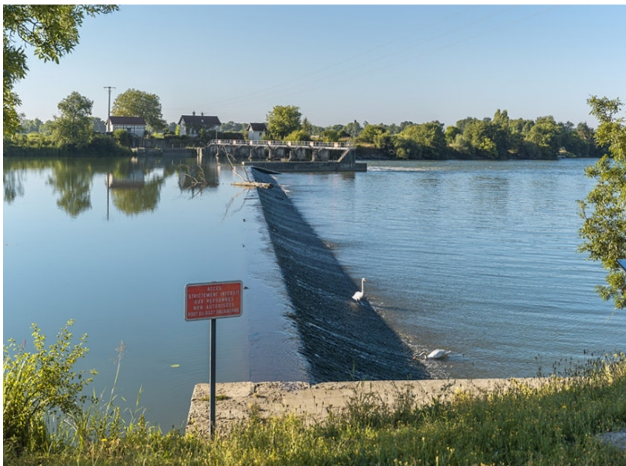
Barrage et maison du barragiste de Poncey (21).
