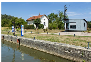
Le site d'écluse de Vereux (70). Phot. Sonia Dourlot IVR43_20157000859NUC4A
