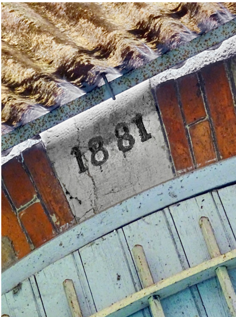
Détail du linteau de l'ancienne maison du barragiste de Charnay (71), détruite en 2019.
