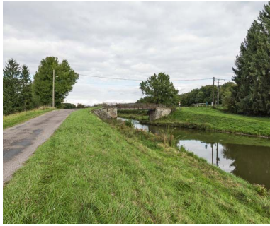
Vue d'ensemble du pont et du site. Phot. Pierre-Marie Barbe-Richaud IVR26_20177100364NUC2A
