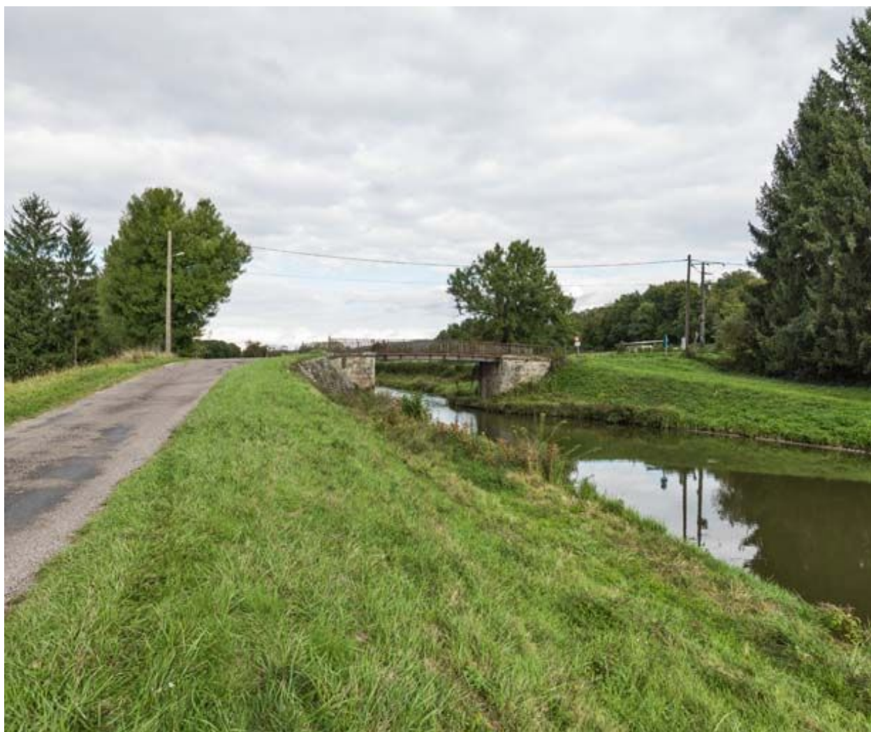
Vue d'ensemble du pont et du site.
