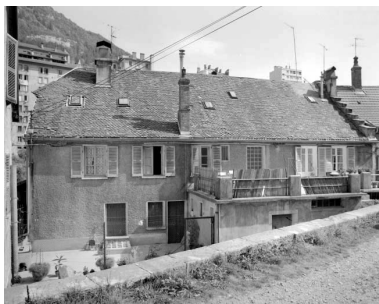
Logement d'ouvriers Dalloz : façade postérieure.
