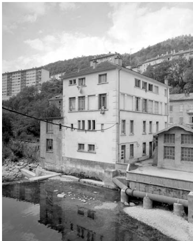
Bureau Dalloz : façades postérieure et latérale gauche. Phot. Jérôme Mongreville IVR43_19923900744X
