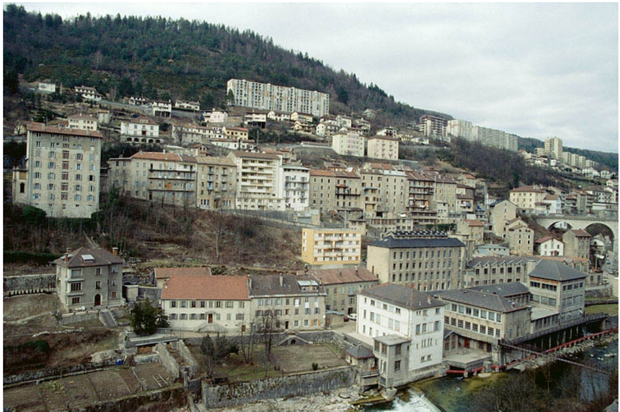
Vue d'ensemble du site depuis le sud-est.
