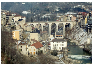
Vue d'ensemble du site depuis le sud. Phot. Laurent Poupard IVR43_19923901362ZA
