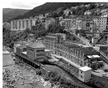
Vue d'ensemble du site depuis le nord-est.
