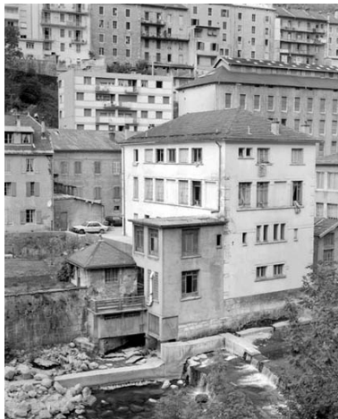
Bureau Dalloz : façades postérieure et latérale gauche. Phot. Jérôme Mongreville IVR43_19923900735X
