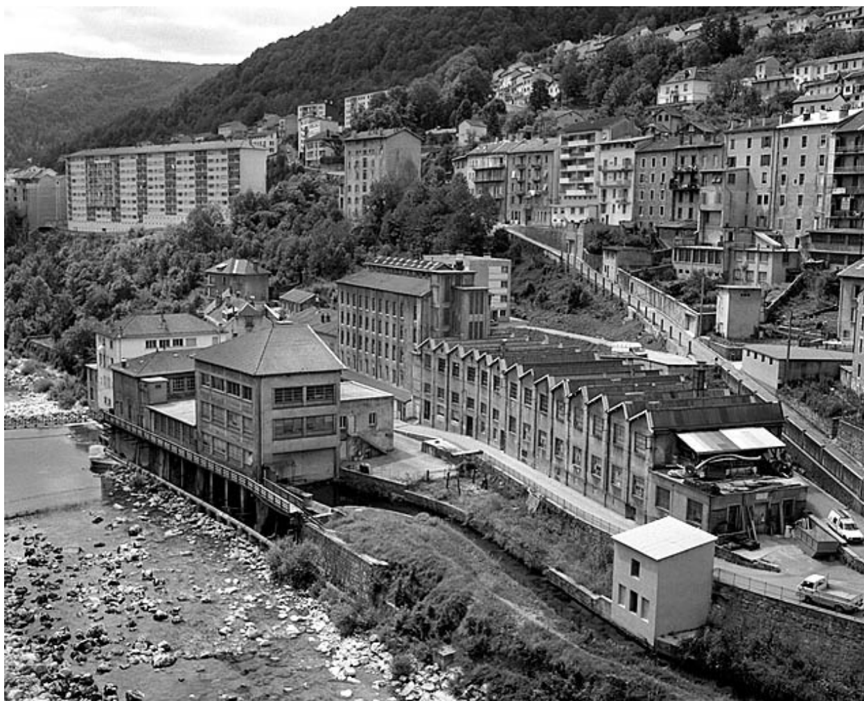
Vue d'ensemble du site depuis le nord-est.
