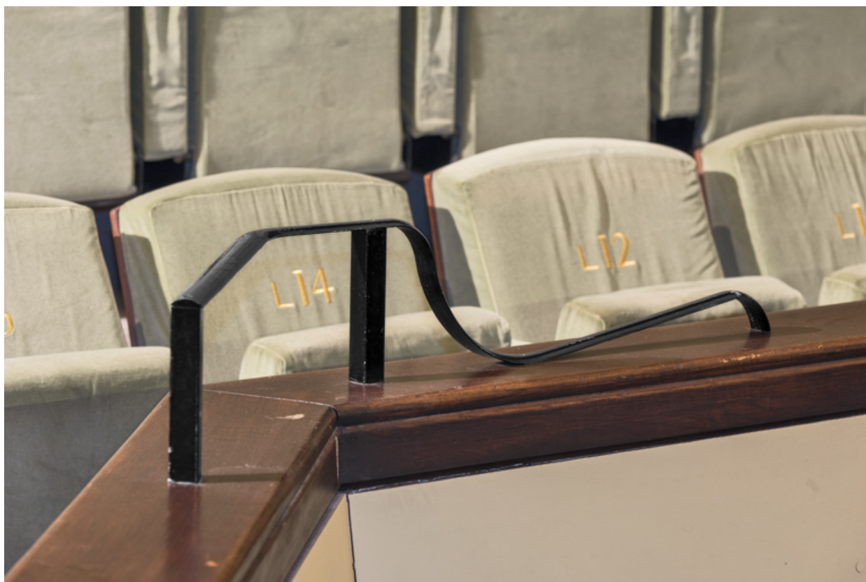
Salle, balcon : ferronnerie sur le garde-corps.
