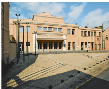
Façade en 1996. Phot. Michel Rosso IVR26_19968901151XA
