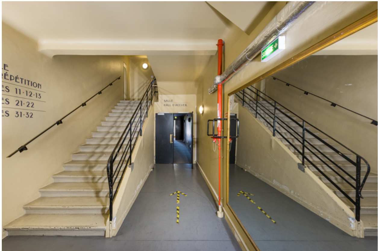
Aile sud : escalier du personnel.
