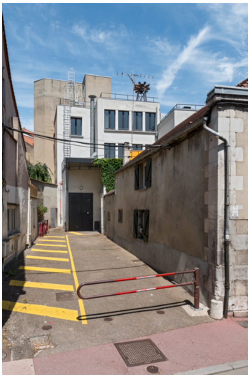
Voie d'accès pour les décors, au sud.
