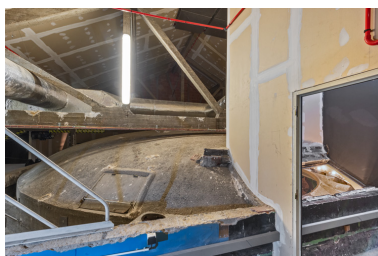
Coupole et régie. Phot. Pierre-Marie Barbe-Richaud IVR26_20238900978NUC4A
