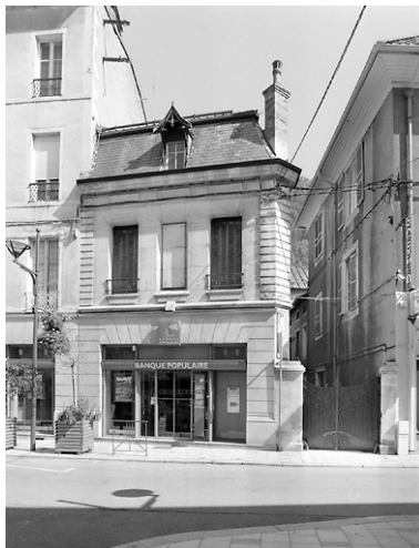
Elévation antérieure. Phot. Yves Sancey IVR43_20033900716X
