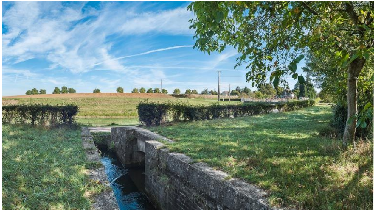
Détail de maçonnerie de la rigole.
