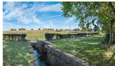
Détail de maçonnerie de la rigole. Phot. Pierre-Marie Barbe-Richaud IVR26_20128900607NUC4AQ
