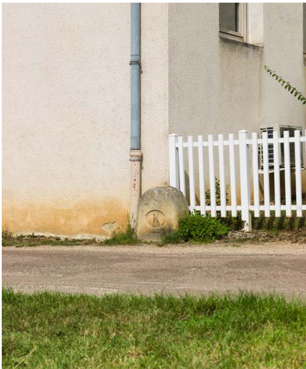
Vue d'ensemble de la borne.
