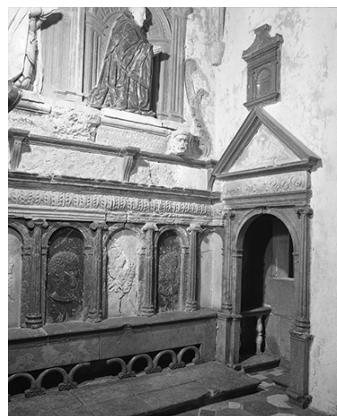
Façade ouest de la chapelle.
