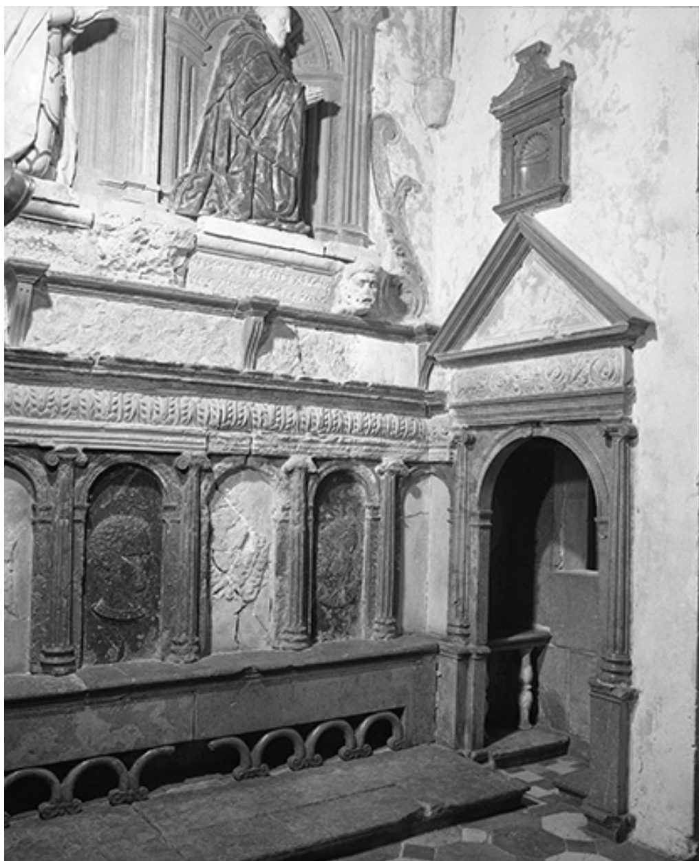
Façade ouest de la chapelle.
