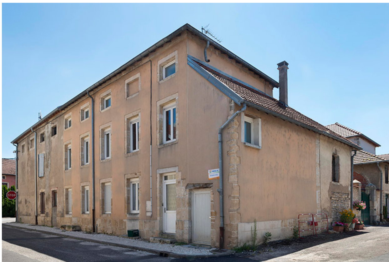
Élévation extérieure sur la rue des Fours.
