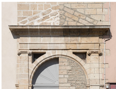
Ancien portail d'entrée, rue Armand-Paulmard, détail. Phot. Jérôme Mongreville IVR43_20187000418NUC4A
