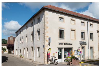
Élévation extérieure sur la rue Armand-Paulmard et la rue des Forges. Phot. Jérôme Mongreville IVR43_20187000416NUC4A
