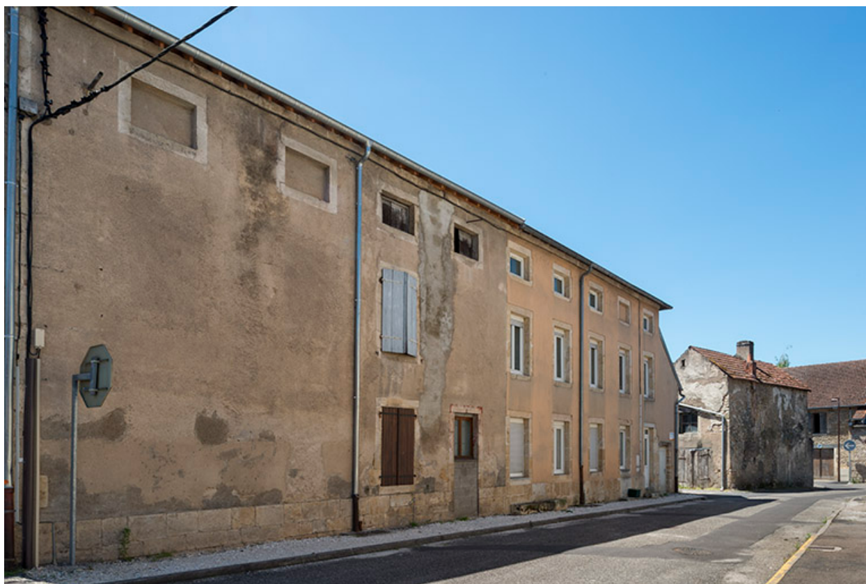
Élévation extérieure sur la rue des Fours.
