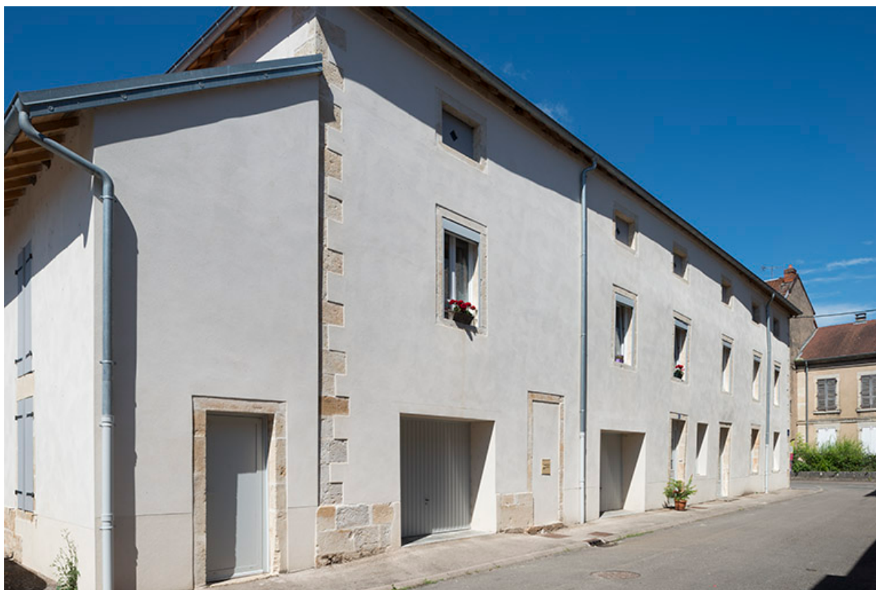
Élévation extérieure sur la rue des Forges.
