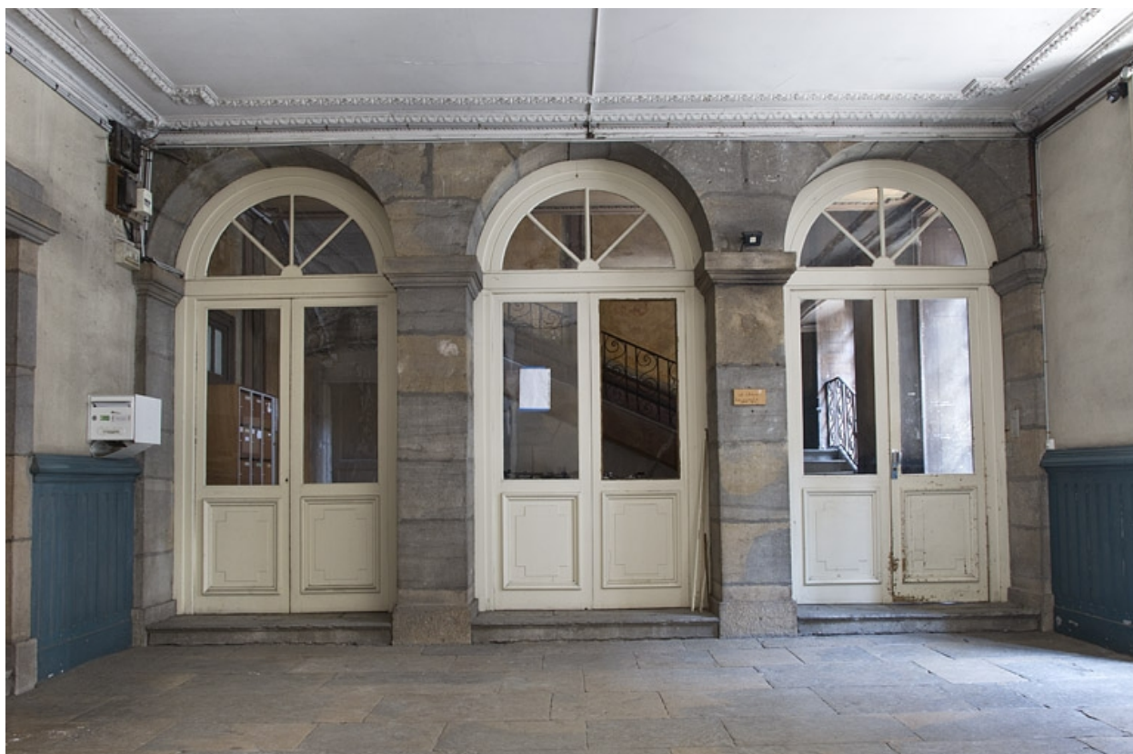
Vue de l'entrée de l'escalier, de face.
