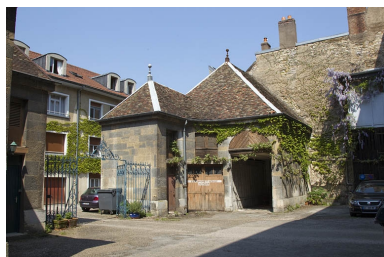
Détail de la remise droite. Phot. Yves Sancey IVR43_20112500787NUC2A
