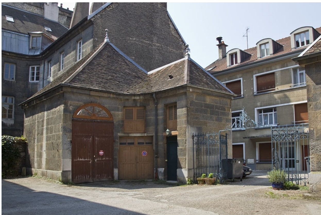
Détail de la remise gauche.
