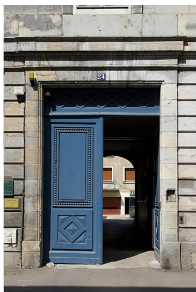
Détail du portail d'entrée.
