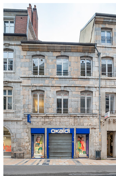
Façade antérieure. Phot. Jérôme Mongreville IVR43_20232500075NUC4A
