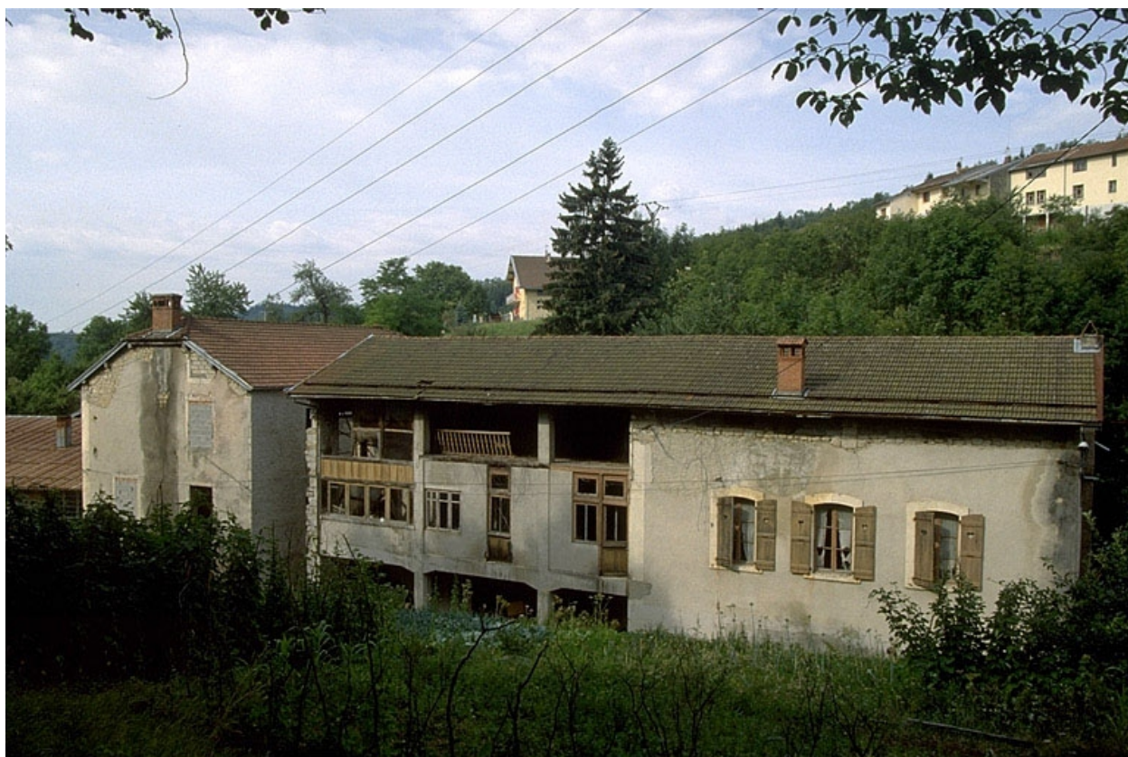
Ancienne tournerie, atelier de fabrication et logement.
