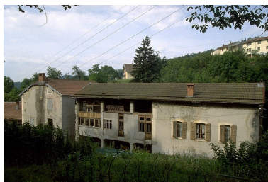
Ancienne tournerie, atelier de fabrication et logement. Phot. Laurent Poupard IVR43_19913901251ZA
