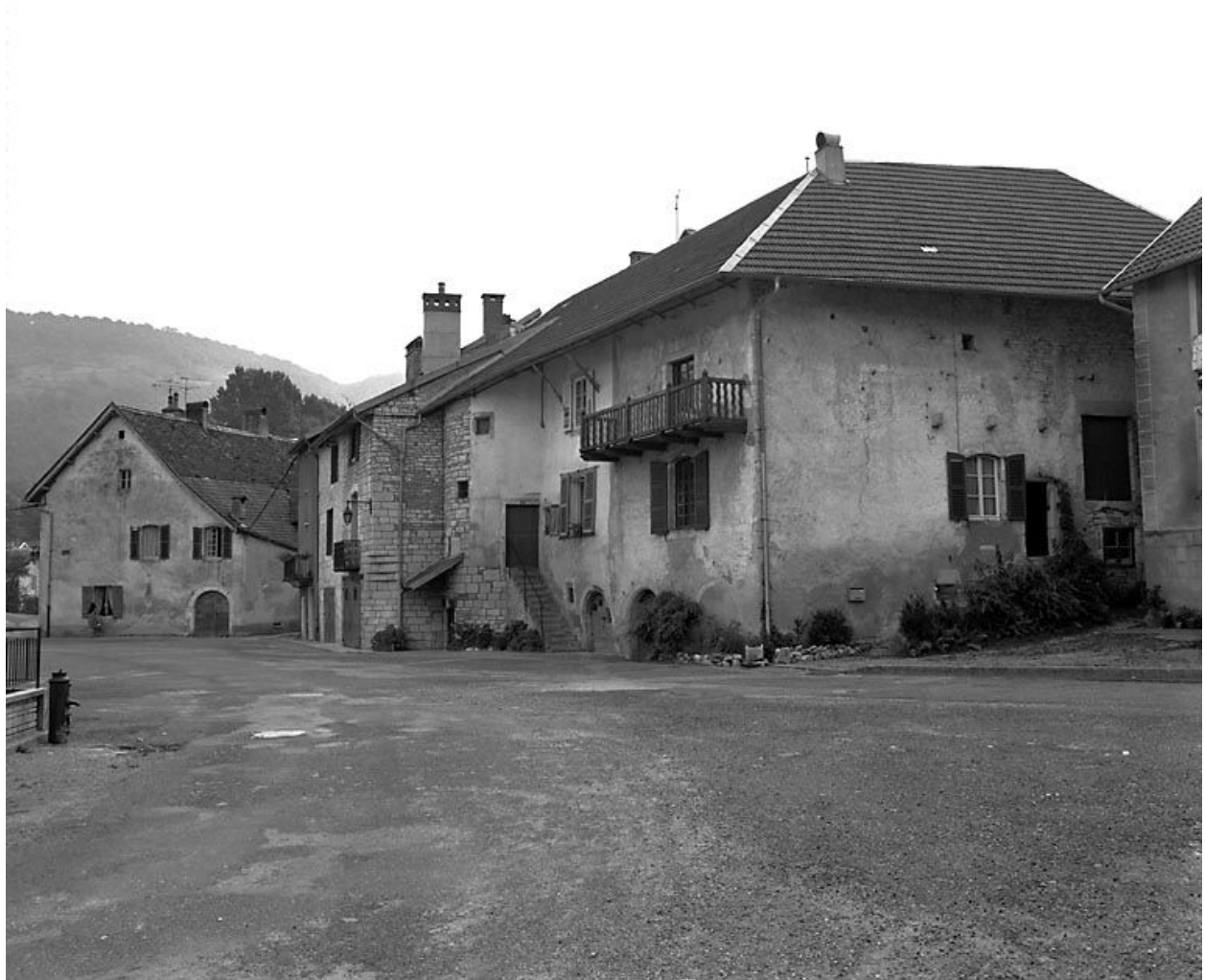
Façade antérieure et face latérale droite.
