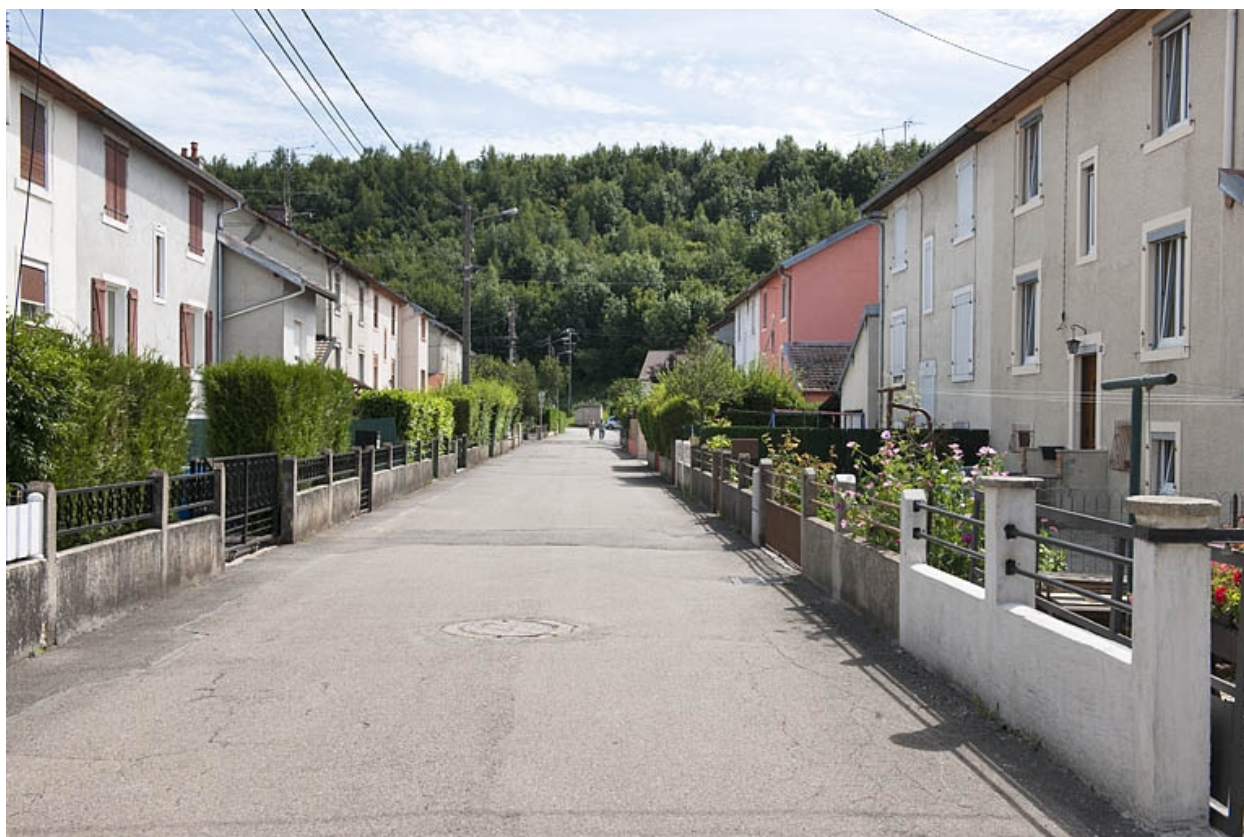
Vue d'ensemble d'une rue.
