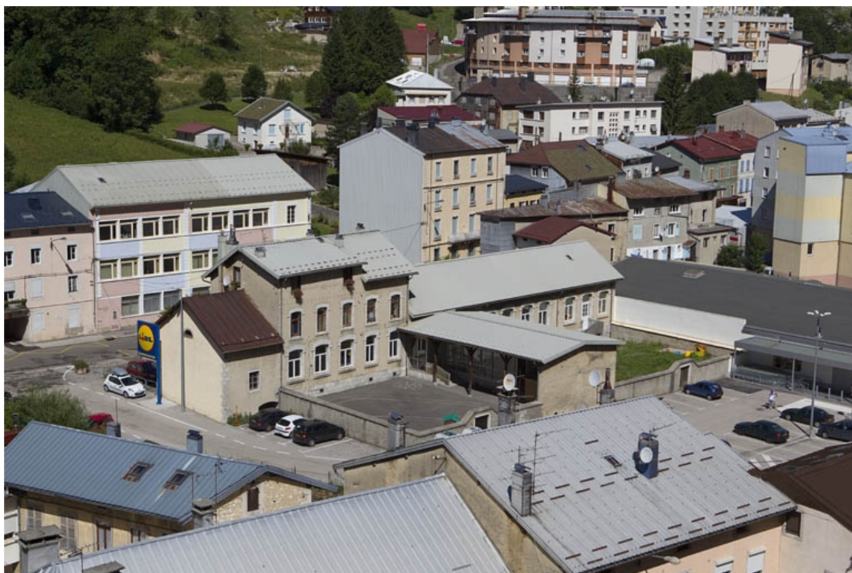
Vue d'ensemble plongeante, depuis l'est.
