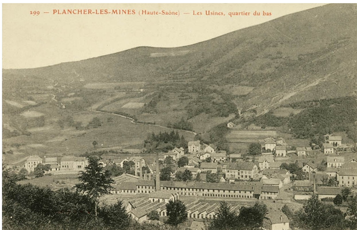
Plancher-les-Mines (Haute-Saône)- Les Usines, quartier du Bas.
