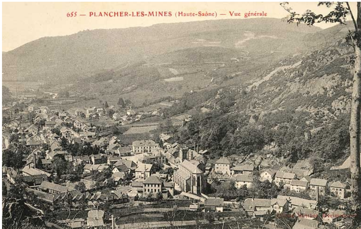
Plancher-les-Mines (Haute-Saône) - Vue générale.
