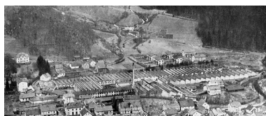
Vue générale des usines. Phot. Jérôme Mongreville, Autr. Drouin IVR43_20027000007X
