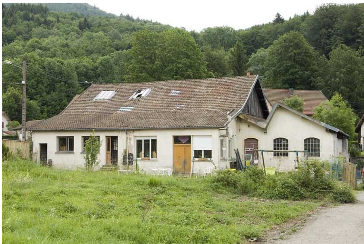
Atelier de réparation (entretien général).
