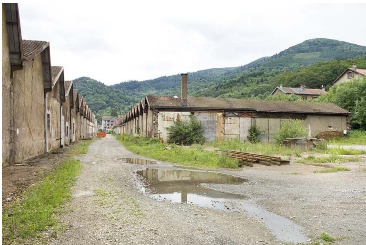
Ateliers de fabrication depuis le sud-ouest.
