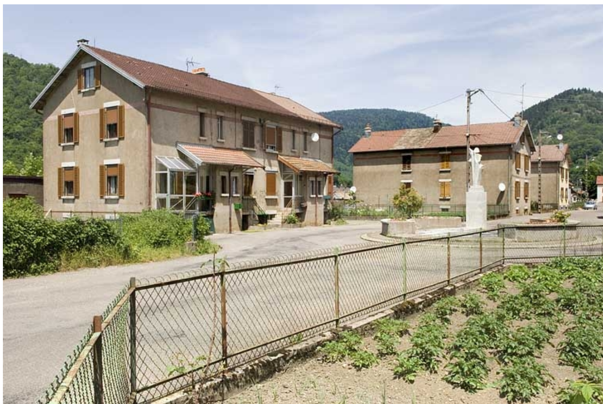
La cité ouvrière depuis le sud.
