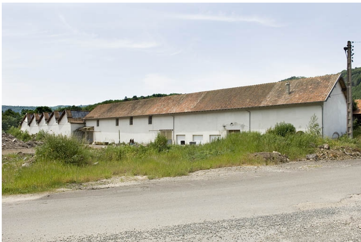
Atelier de fabrication (boulonnerie) depuis l'est.
