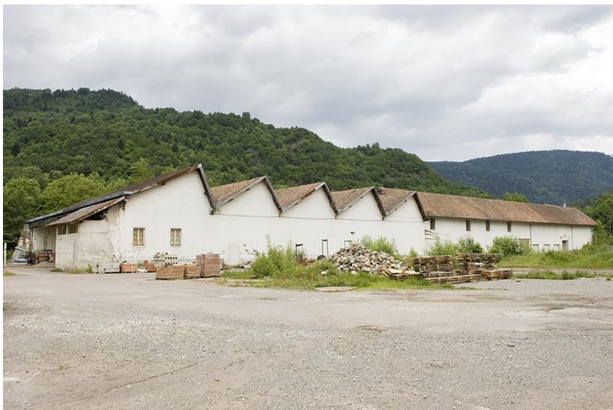
Atelier de fabrication (boulonnerie) depuis le sud.
