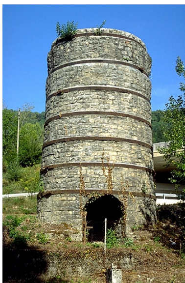
Usine de chaux et ciment Bouvet Ponsar et Cie, Champagnole : un ancien four à chaux. Phot. Yves Sancey IVR43_19973901560ZA
