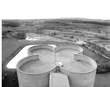
Cimenterie de la S.A. Ciments de Champagnole, Rochefort- sur-Nenon : silos et carrière. Phot. Yves Sancey IVR43_19883900625X
