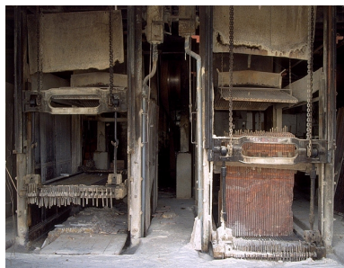
Marbrerie Célard, Saint-Amour : deux châssis de scie multilames Décamps. Phot. Yves Sancey IVR43_19933900277ZA
