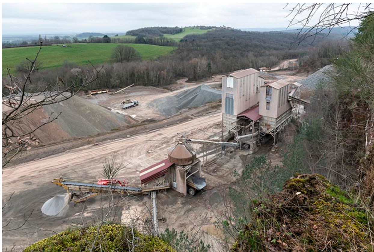
Carrière de Moissy : installations de concassage.
