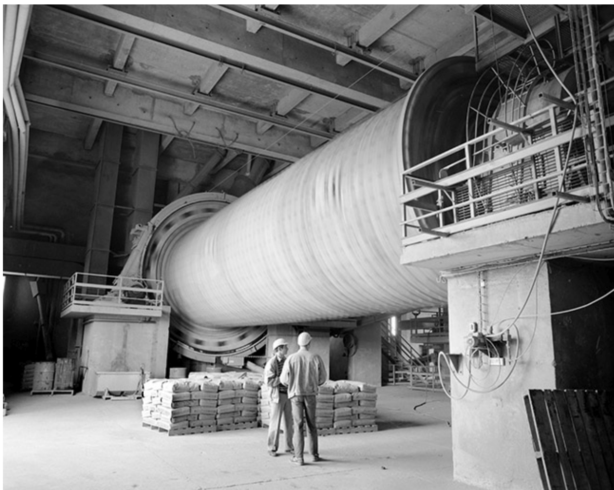
Cimenterie de la S.A. Ciments de Champagnole, Rochefort-sur-Nenon : broyeur de clinkers.
