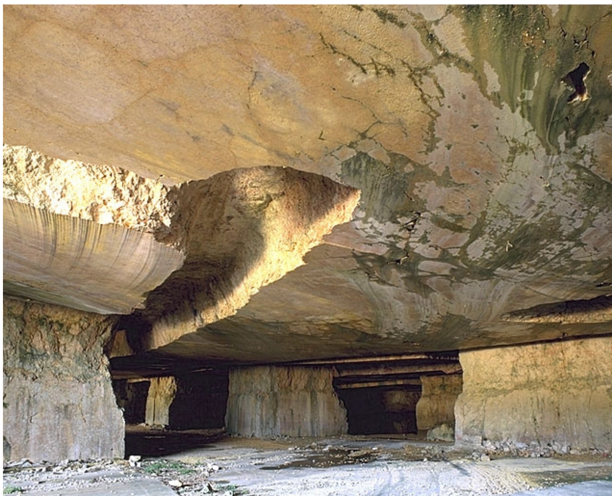
Carrière souterraine de Chassal.
