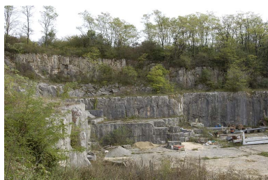
Carrière Marlin, Dole (les Bruyères). Phot. Jérôme Mongreville IVR43_20053900482NUCA
