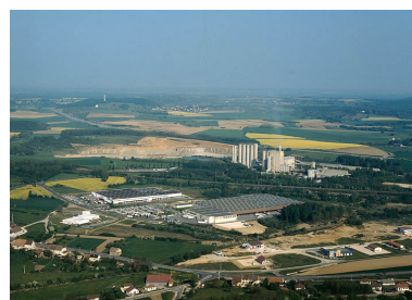
Cimenterie de la S.A. Ciments de Champagnole, Rochefort-sur-Nenon. Phot. Yves Sancey IVR43_19903900269XA
