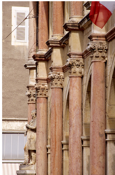
Marbre de Sampans : hôtel de ville, Gray. Phot. Yves Sancey IVR43_19977000043ZA
