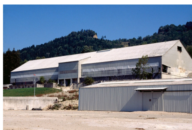
Usine de chaux et ciment Bouvet Ponsar et Cie, Champagnole : hall de préhomogénéisation. Phot. Yves Sancey IVR43_19973901550ZA
