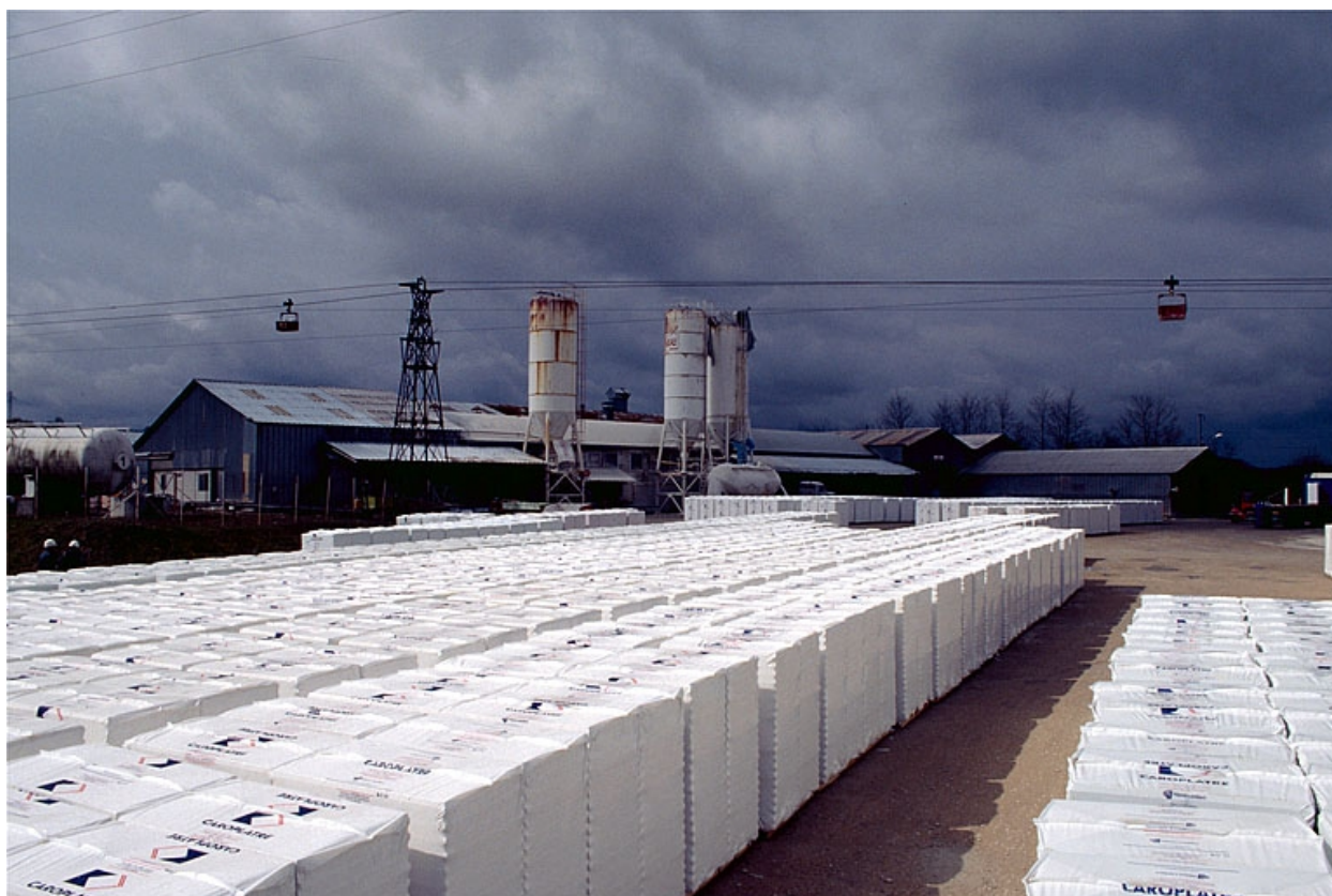
Plâtrières modernes de Grozon.
