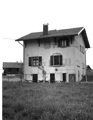
Façade sud-est. Phot. Jérôme Mongreville IVR43_20013900563X
