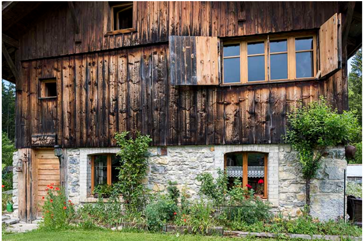
Façade antérieure : baies.
