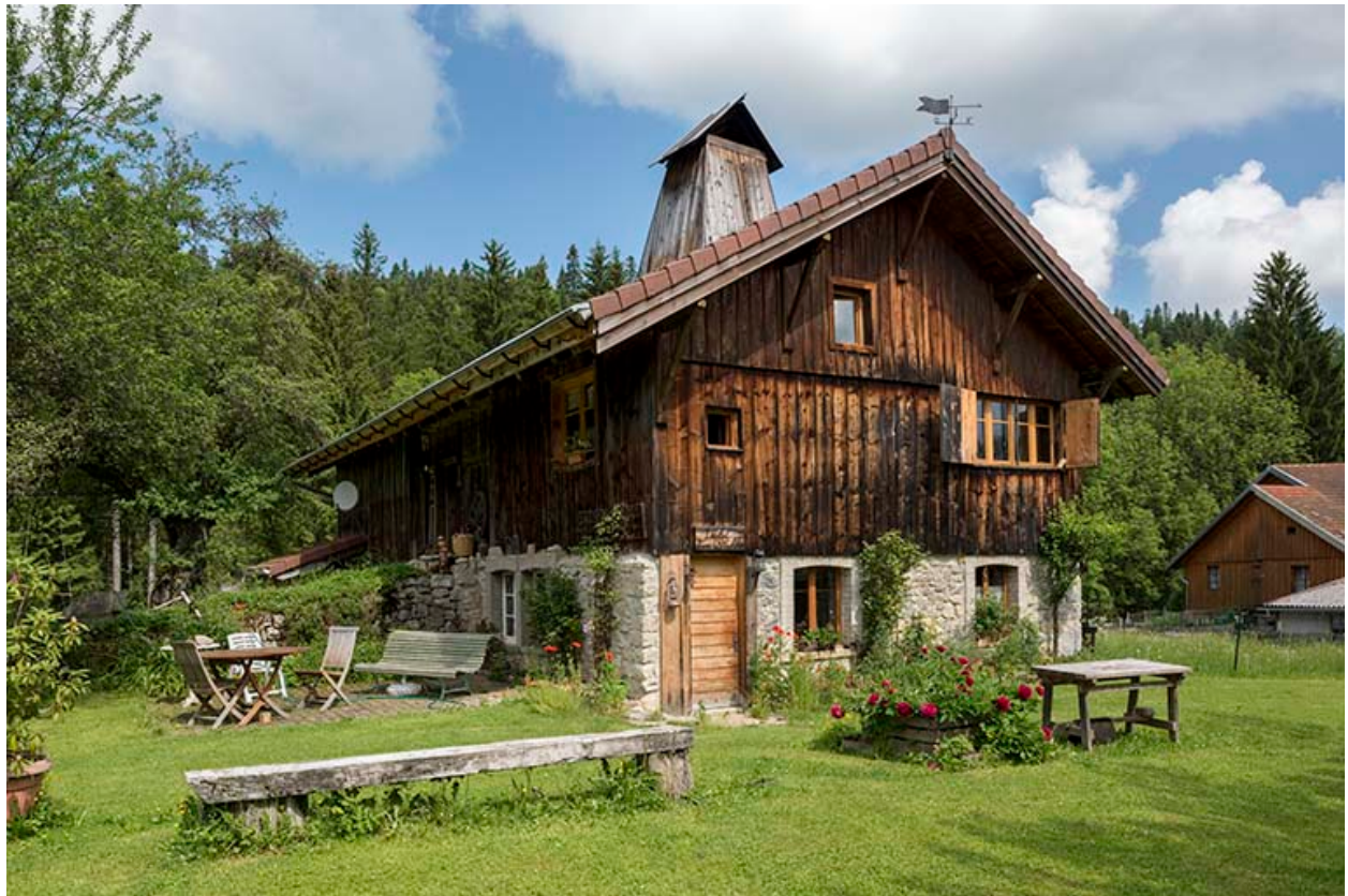
Façades antérieure et latérale gauche.
