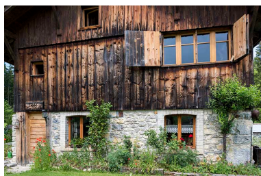
Façade antérieure : baies. Phot. Sonia Dourlot IVR43_20172500458NUC4A
