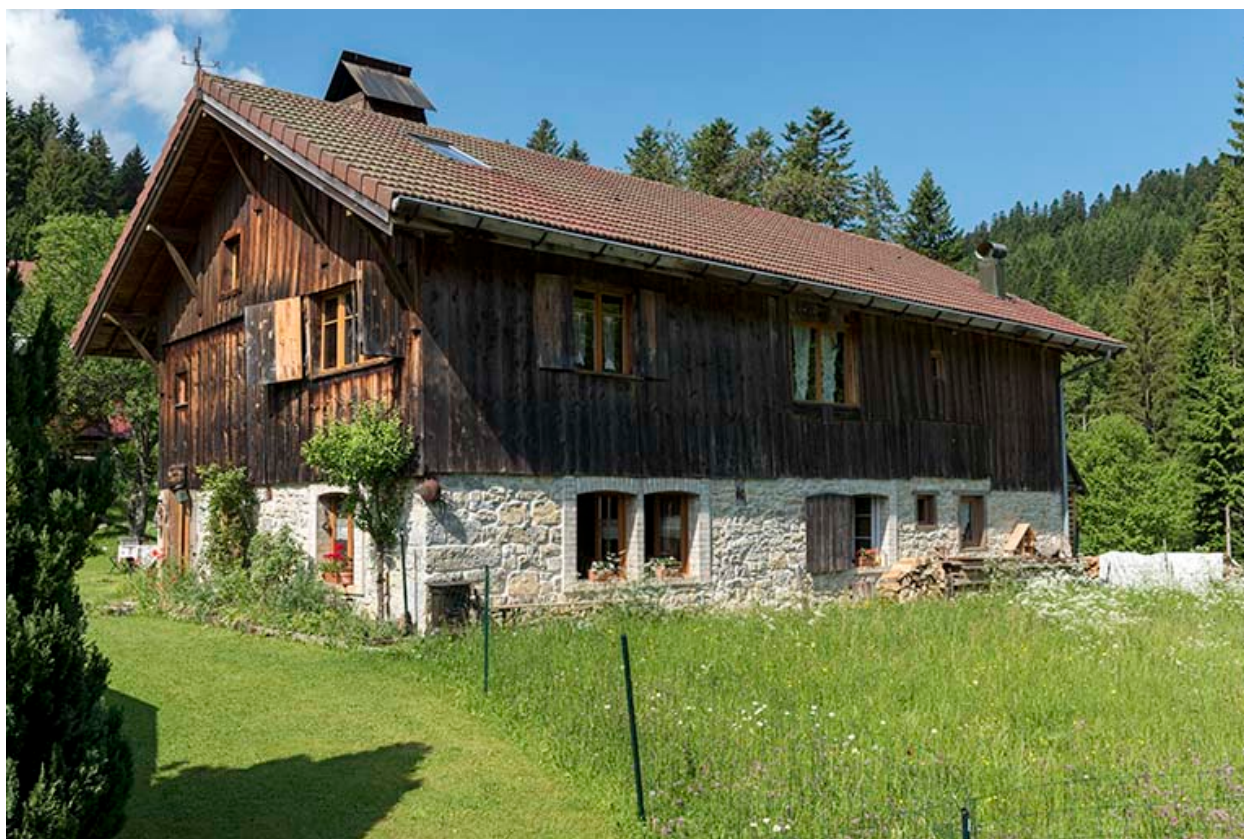
Façades antérieure et latérale droite.
