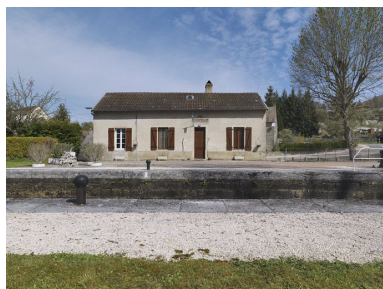
Maison éclusière de face. Phot. Thierry Kuntz IVR26_20122102438NUC4A
