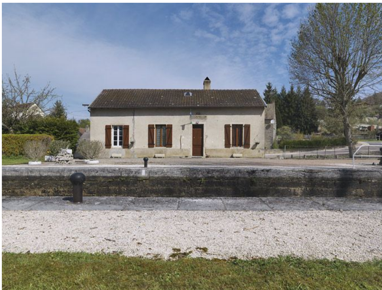
Maison éclusière de face.
