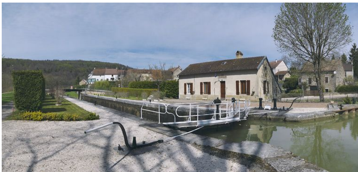
Vue d'ensemble de l'amont du site d'écluse.
