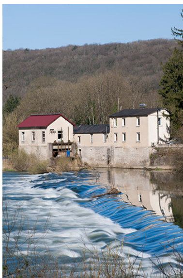
Vue depuis la rive gauche du barrage. Phot. Jérôme Mongreville IVR43_20152501006NUC4A
