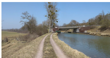
Vue d'ensemble du pont. Phot. Thierry Kuntz
