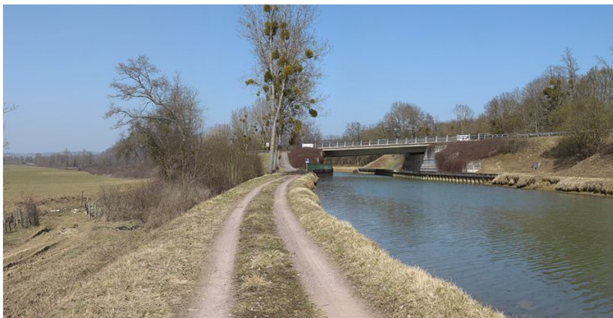
Vue d'ensemble du pont.
