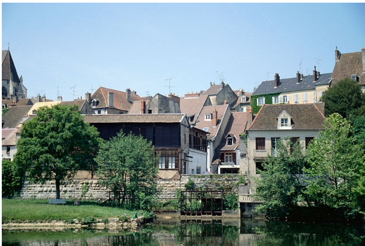
Pièce de séchage, depuis l'est.
