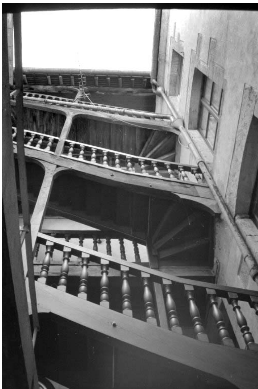
Escalier de distribution extérieur (D).
