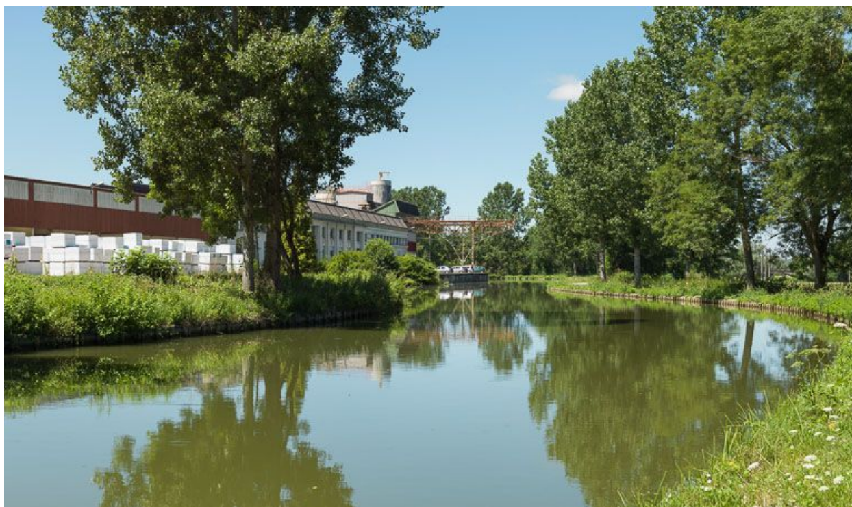
Vue d'ensemble de l'usine, rive gauche.
