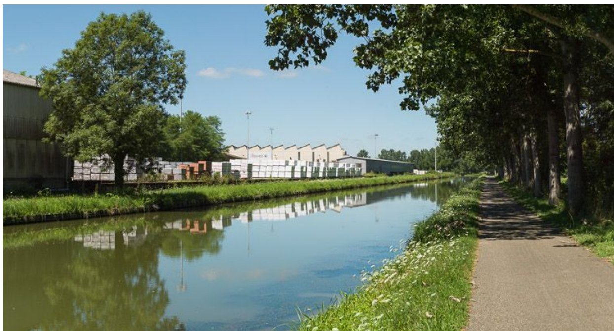
Vue d'ensemble d'amont.
