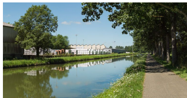
Vue d'ensemble d'amont. Phot. Pierre-Marie Barbe-Richaud IVR26_20137100527NUC4AQ
