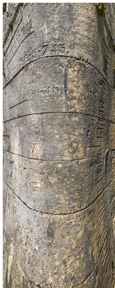
Détail de l'échelle de crue sur la culée du pont. Phot. Thierry Kuntz IVR26_20192100216NUC4A
