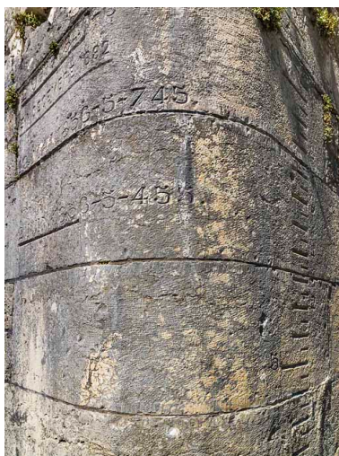
Détail de l'échelle de crue sur la culée du pont. Phot. Thierry Kuntz IVR26_20192100218NUC4A
