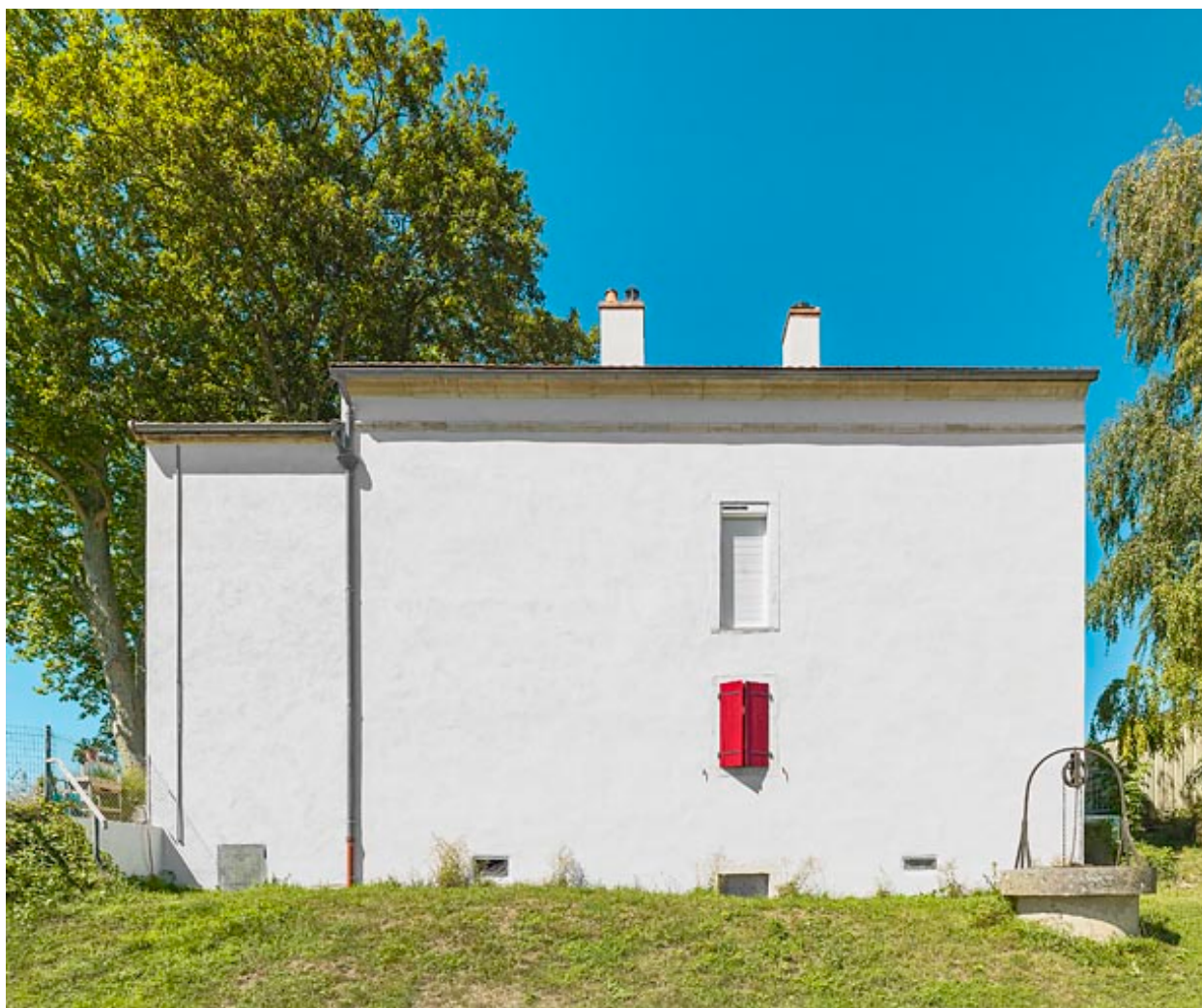
La maison éclusière : face arrière.
