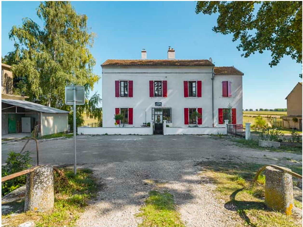
La maison éclusière : façade principale.
