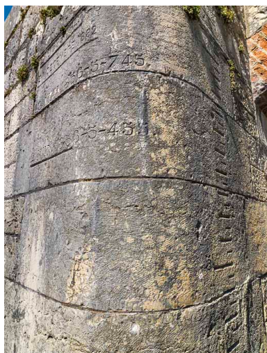
Détail de l'échelle de crue sur la culée du pont. Phot. Thierry Kuntz IVR26_20192100217NUC4A
