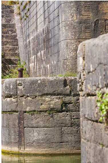
Echelle de crue sur la culée du pont et sur le bajoyer.
