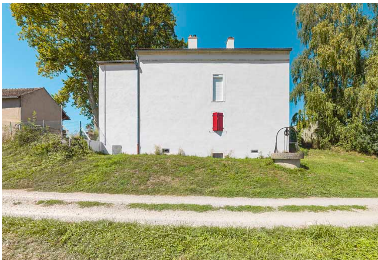
La maison éclusière : face arrière.
