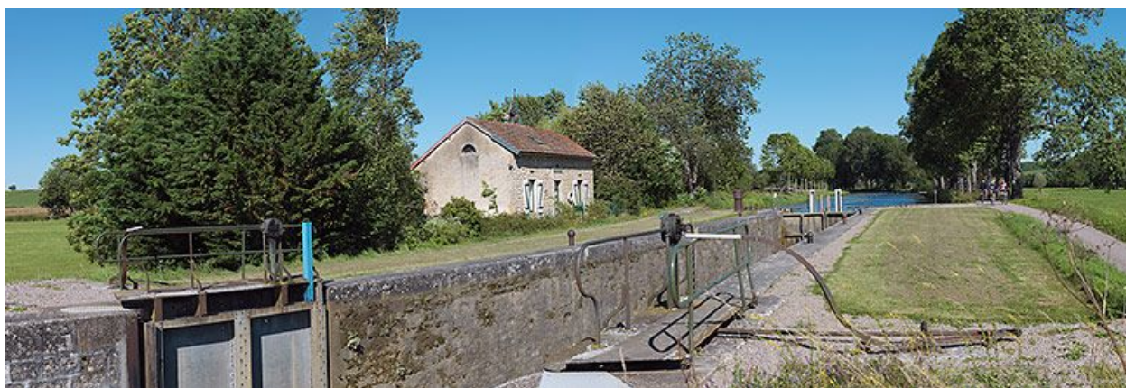
Vue d'ensemble du site pris d'aval.
